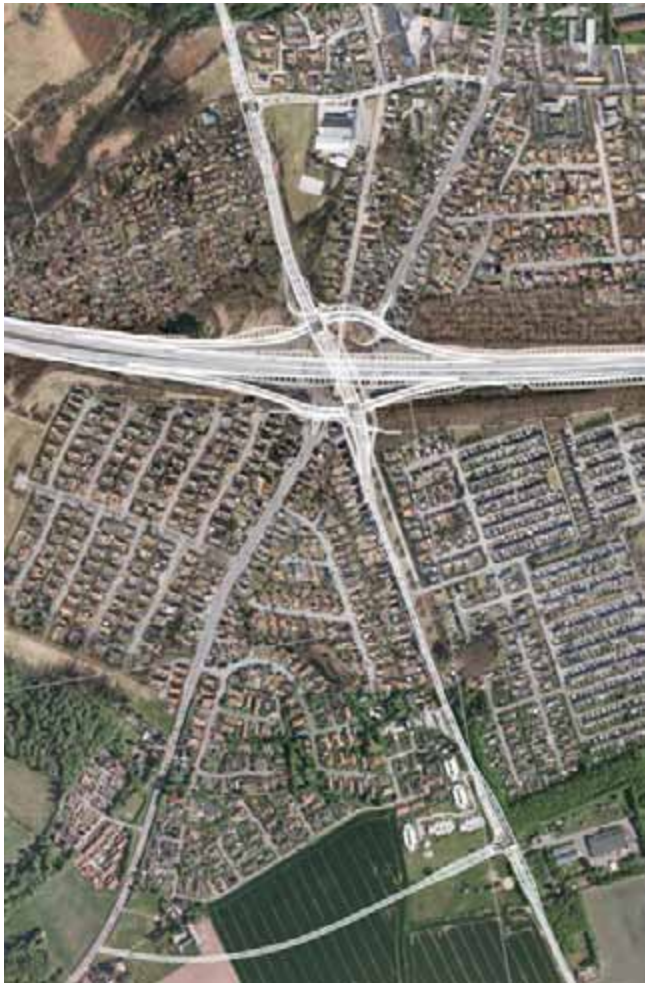
FIGUR 4.3 Ruderanlæg med forbindelsesveje ved TSA 51
