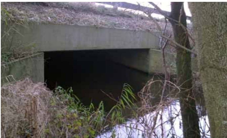
FIGUR 6.2 Underføringen af Lindved Å set fra motorvejens sydside.
