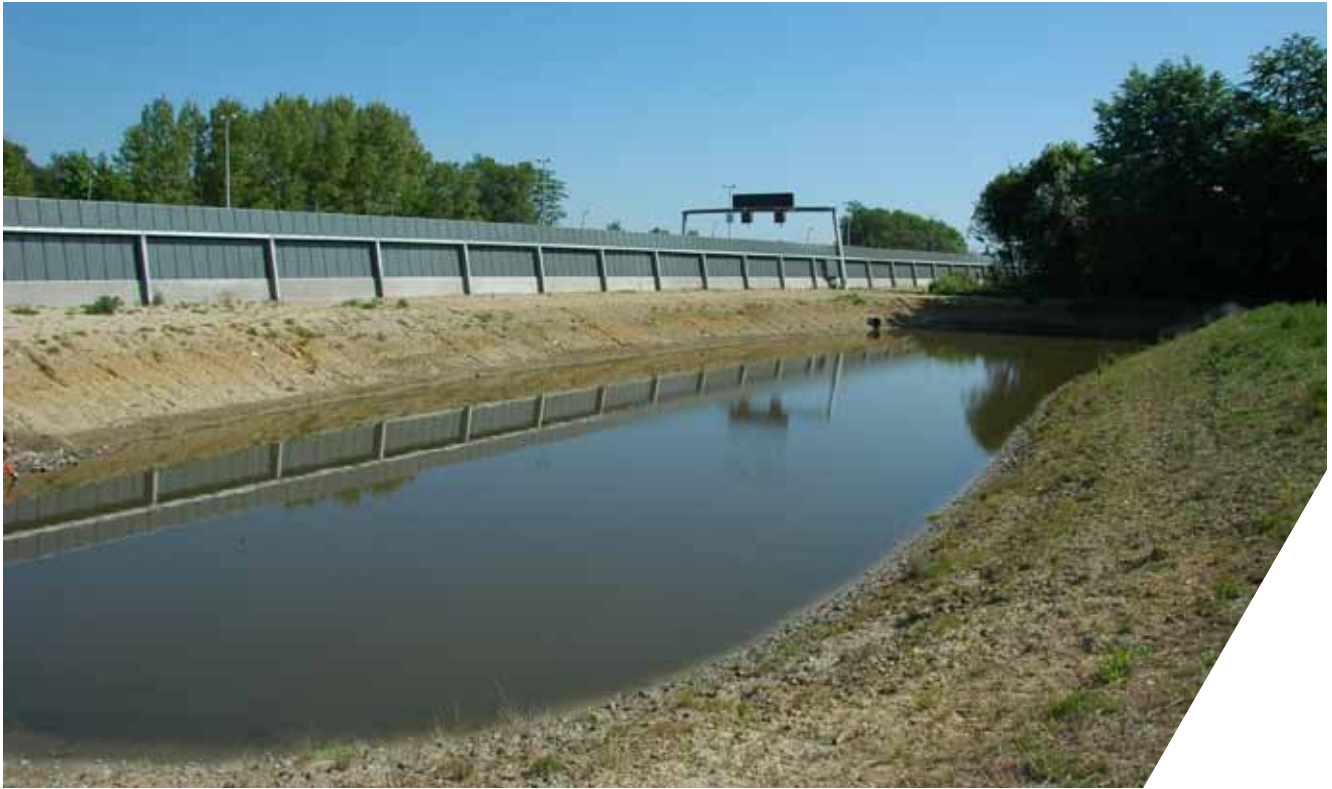
FIGUR 10.9 Eksempel på nyanlagt vejvandsbassin.
