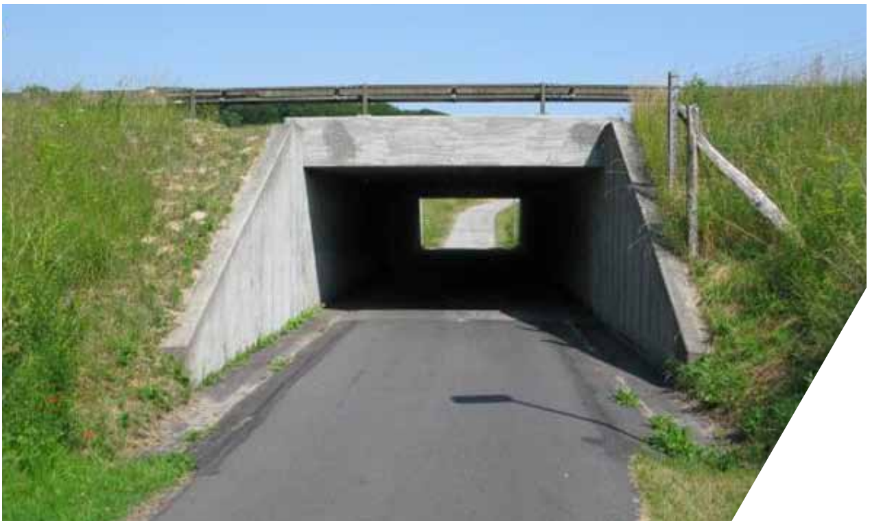
FIGUR 9.12 Gang- og stitunnel ved Hollufsgårdsvej øst for Lindved Å (Rambøll 2010).
