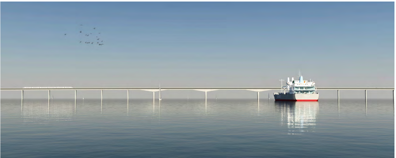
Figur 4.7 Bjælkebro med sidefag og gennemsejlingsfag
