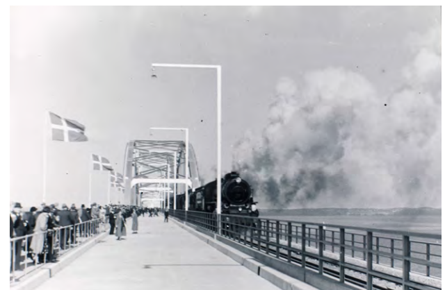
Figur 6.2 Storstrømsbroen under anlægsarbejdet i 1934 - 37
