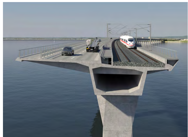
Figur 4.3 Ny Storstrømsbro med et enkelt brodæk og en enkelt søjle, som er den foretrukne løsning
