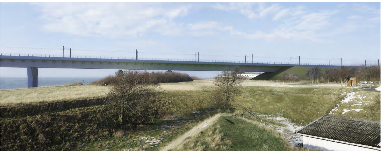
Figur 9.19 Udsyn fra Masnedø Fort mod vest med den nye Storstrømsbro. Dæmningen er tilbagetrukket af hensyn til at bevare udsynet mest muligt.
