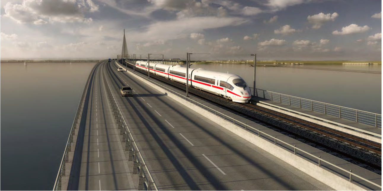
Figur 4.6 Broens tværsnit med sti, vej og jernbane set fra syd med pylonløsningen.
