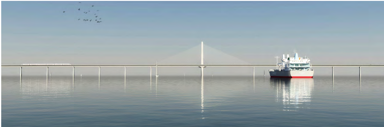
Figur 1.1 Skråstagsbro med sidefag og gennemsejlingsfag
