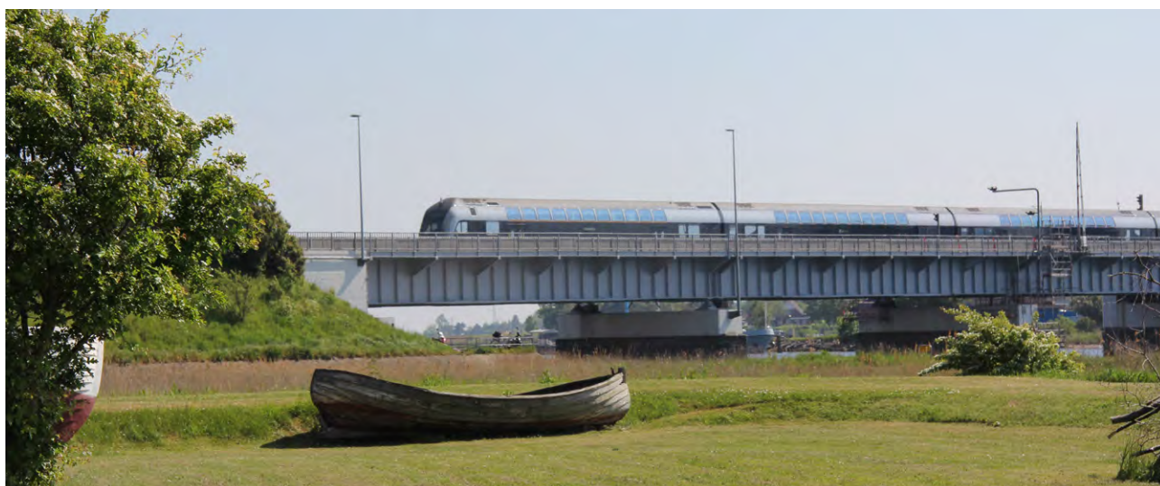
Figur 11.2 Foto af den eksisterende Masnedsund bro med passage af tog
