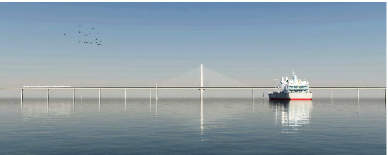
Figur 4.8 Skråstagsbro med sidefag og gennemsejlingsfag
