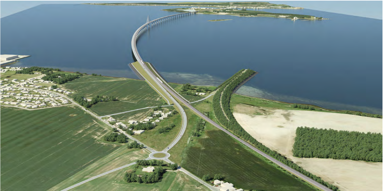
Figur 1.4 Landanlæg på Falster med Orehoved og Masnedø i baggrunden
