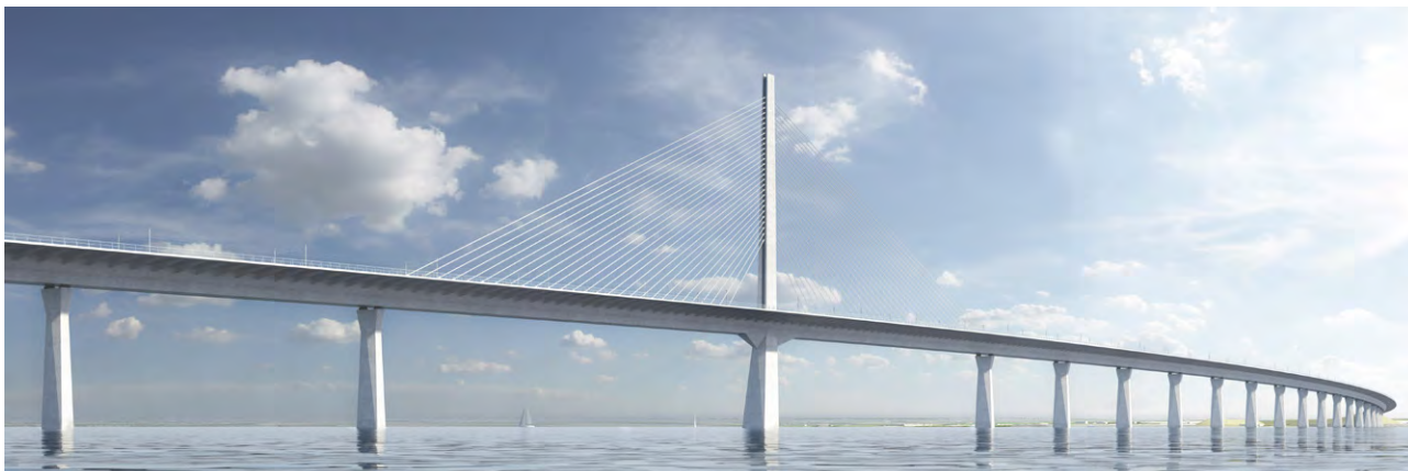
Figur 4.4 Ny Storstrømsbro med pylonløsning
