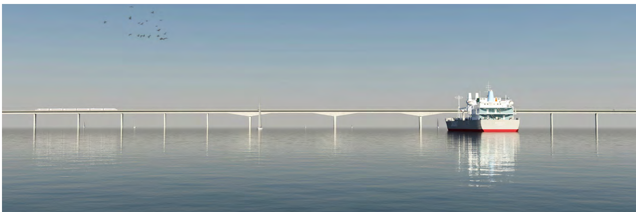
Figur 1.2 Bjælkebro med sidefag og gennemsejlingsfag
