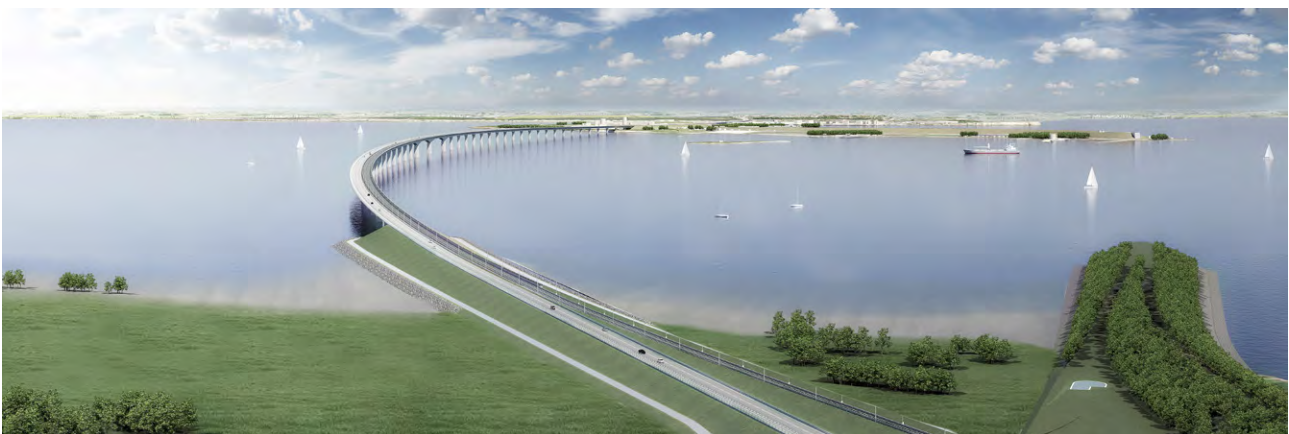
Figur 9.13 Den nye Storstrømsbro, set fra Falster. Den nye Storstrømsbro er her vist som bjælkebro.
