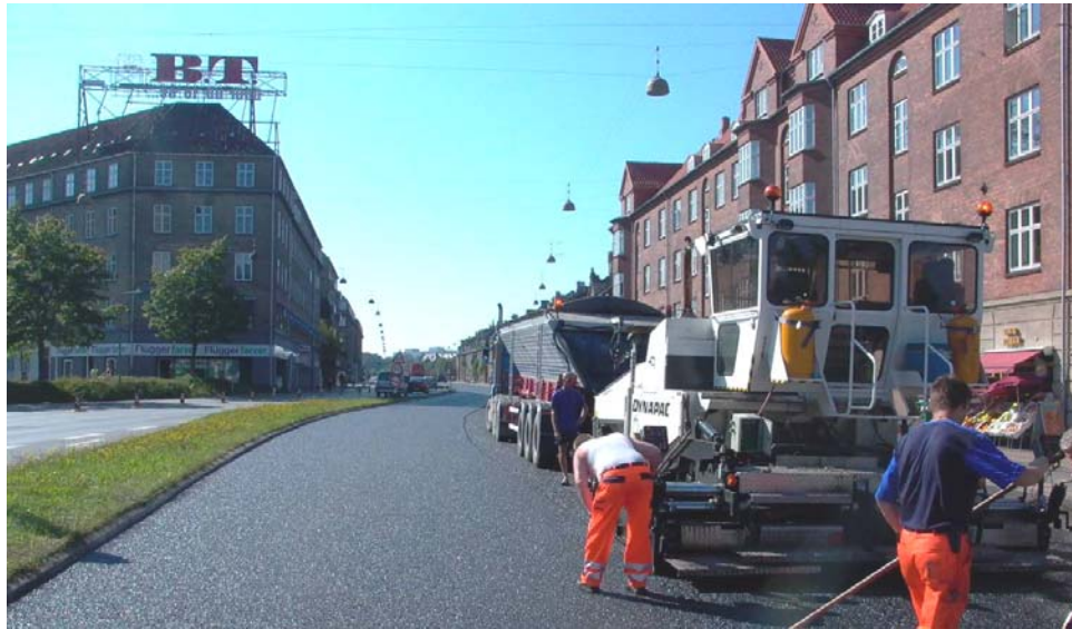
Figur 6.6. Når belægningen på en eksisterende vej skal fornyes, kan vejmyndigheden beslutte at anvende en støjreducerende vejbelægning. På dette billede udlægges to-lag støjreducerende drænasfalt på Lyngbyvej i København.
