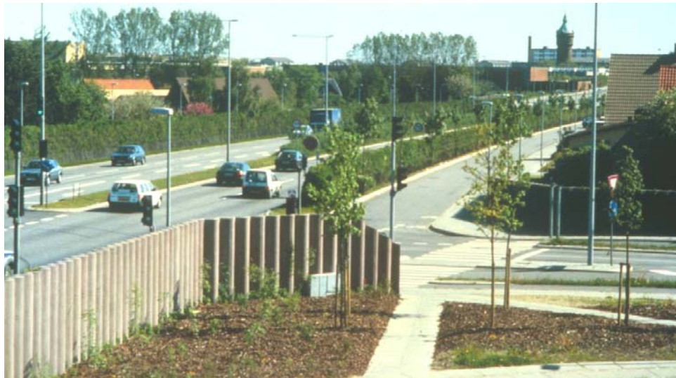
Figur 4.4. Kombination af bølgeformede indfarvede betonskærme samt grønne støjskærme opført som en "støttet" jordvold med beplantning langs ringgaden i Århus.
