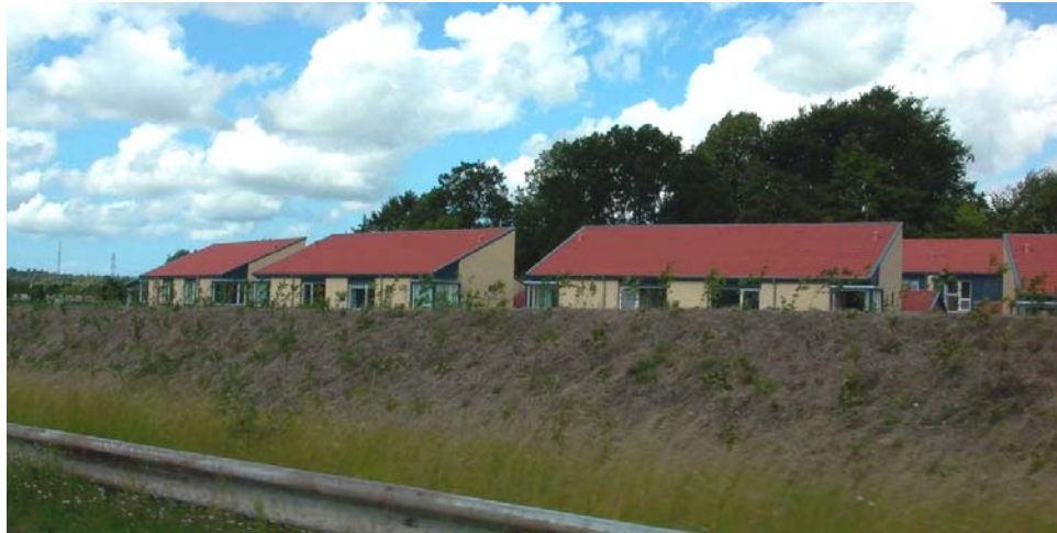
Figur 7.1. Jordvolde opført samtidig med et nyt boligområde for at reducere støjen fra en eksisterende vej ved Kvistgård i Nordsjælland.
