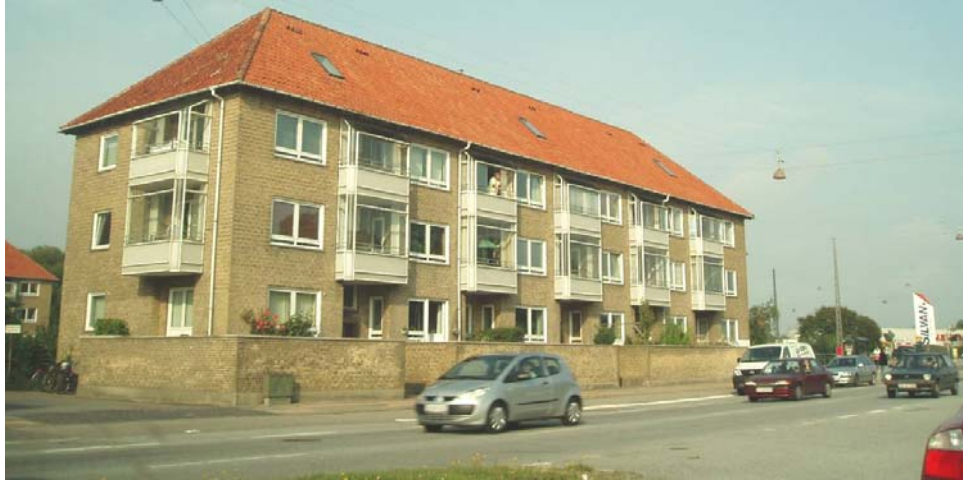
Figur 4.6. Facadeisolering udført på en etageejendom i København, hvor altanerne er blevet inddækket med glas.
