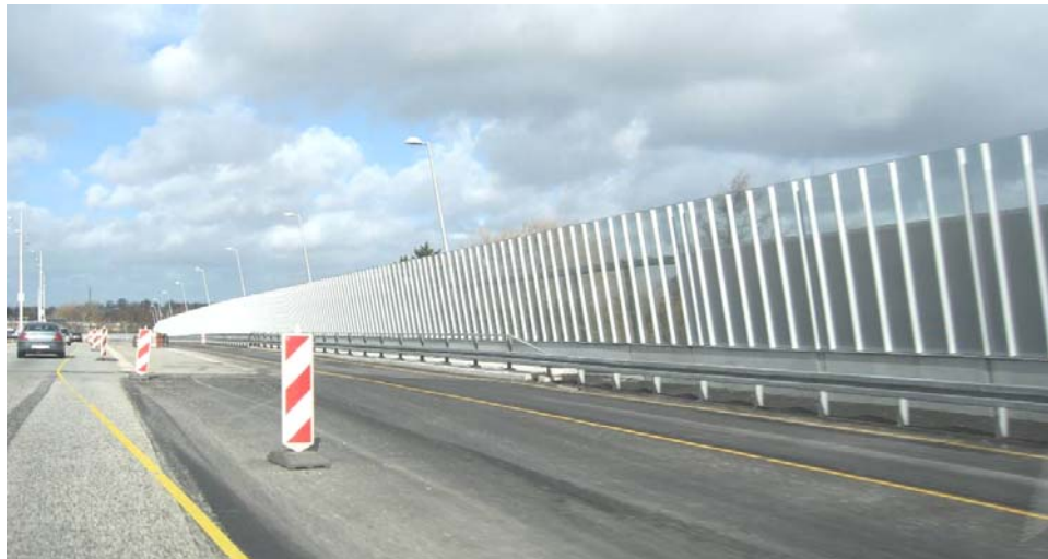
Figur 5.2. 3 til 4 m høje støjskærme er blevet bygget langs Motorring 3 som en del af vejudvidelsesprojektet.
