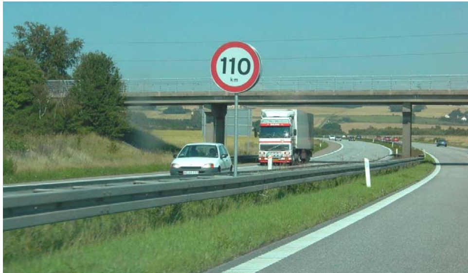
Figur 6.12. Reduktion af hastigheden på en del af en vejstrækning, der passerer et støjfølsomt område kunne være en løsning. Denne løsning har dog kun en betydning for støjen hvis den gennemsnitlige hastighed rent faktisk bliver reduceret. En løsning kunne evt. være at anvende hastighedsbegrænsning i aften og natperioderne for at reducere støjgenen, når beboerne sover.
