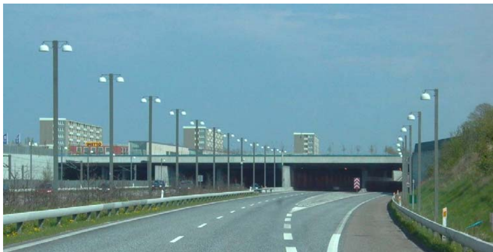
Figur 4.5. 700 m af Øresundsmotorvejen ved Tårnby er gravet ned under terræn og der er bygget et betondæk over vejen for at reducere støjen ved nogle nærliggende etageboliger.
