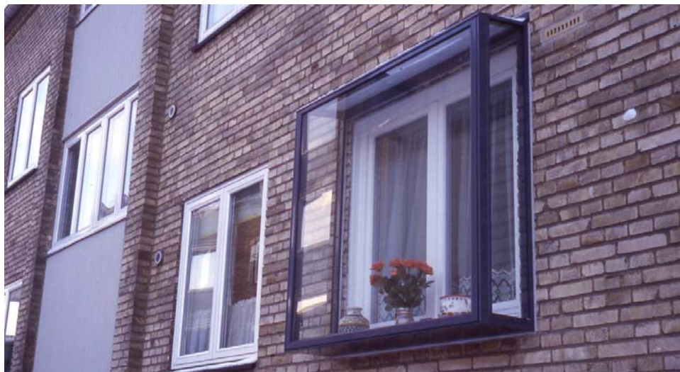
Figur 1.1. Eksempel på facadeisolering hvor der er opsat glaskasser foran de eksisterende vinduer ved soveværelser og stuer på en boligblok i Århus [10].
