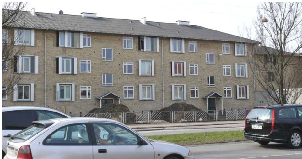
Figur 6.9. Forsøg med en "lydskodde". Lydskodden er et støjsolerende vindue, der er monteret på skinner uden på de eksisterende vinduer. Med lydskodden er det muligt at åbne det eksisterende vindue og samtidig få frisk luft ind uden at blive væsentligt generet af støj. Hensigten er, at skodden dæmper støjen med ca. 15 dB, når vinduet er åbent, og skodden er skudt for. Skodden virker som et udvendigt fortsatsvindue. I siderne på skodden er der en ca. 3 cm bred sprække, som gør, at udeluften kan trænge ind, samtidig med at støjen dæmpes. Ønsker man en større udluftning, kan skodden skydes fra vinduet. Opsat ved soveværelser og opholdsstuer i en almen boligforening, Folehaven, København(foto Allan Jensen, Rambøll).
