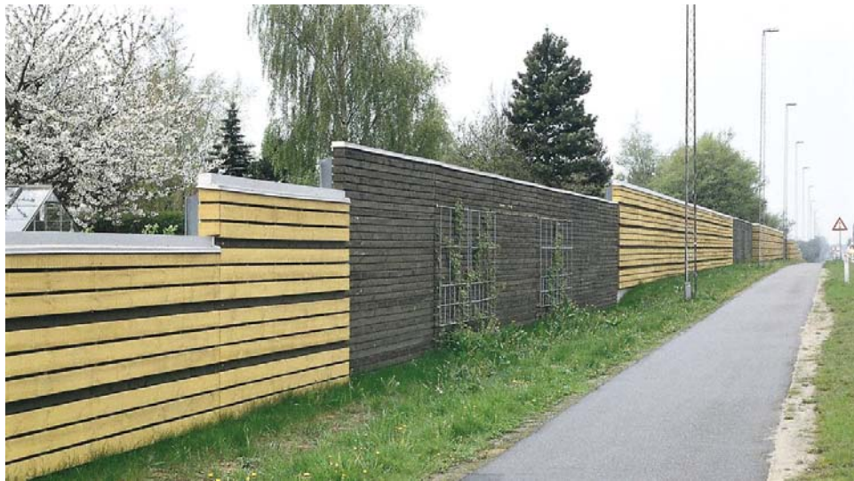
Figur 6.1. Støjskærm i træ opført langs en eksisterende vej [2].
