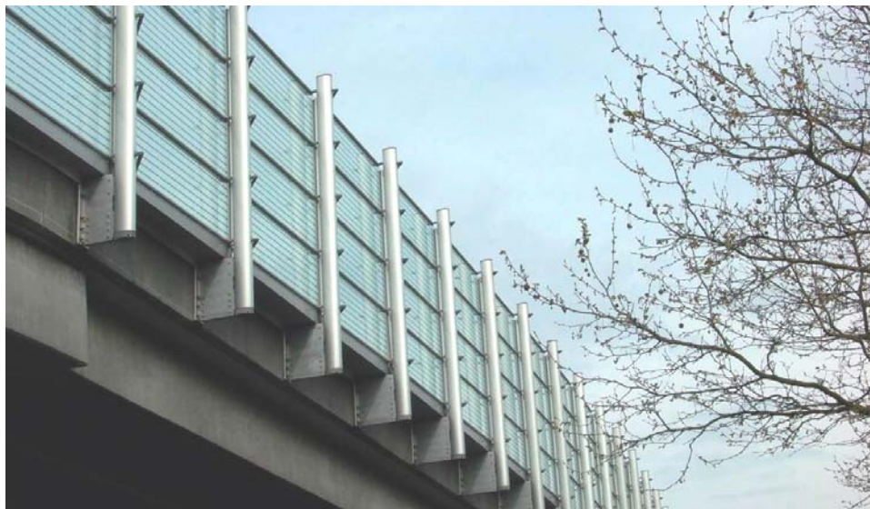
Figur 6.3. Overordnet vej på bro gennem tæt befolket boligområde med ejendomme med 5 til 6 etager i Frederiksberg/København. For at reducere støjen er her anvendt en kombination af transparente støjskærme samt facadeisolerings.
