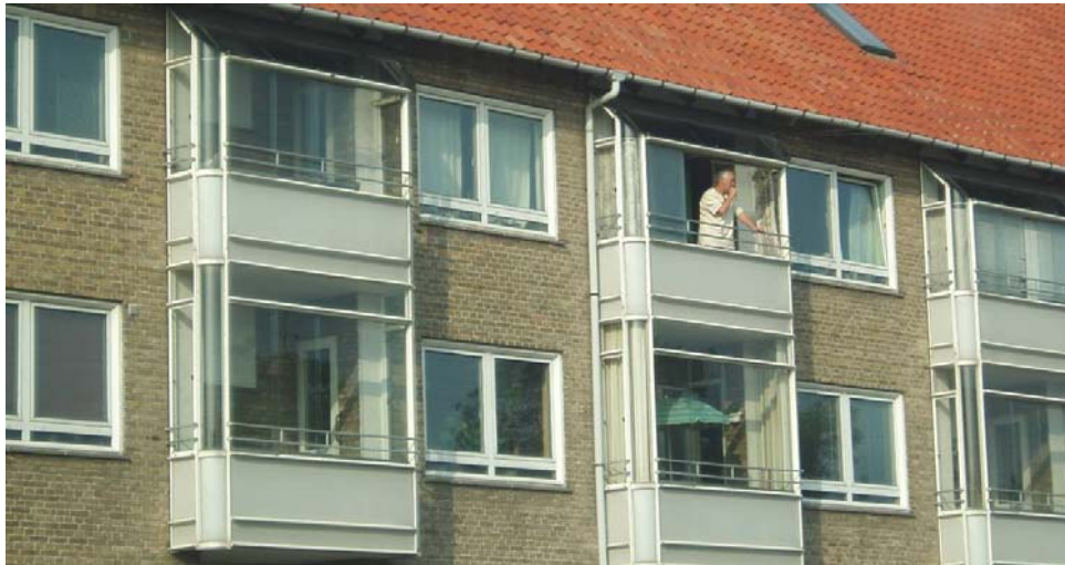
Figur 4.7. Nærbillede af de glasinddækkede altaner. Det er muligt for beboerne at åbne altanerne op.
