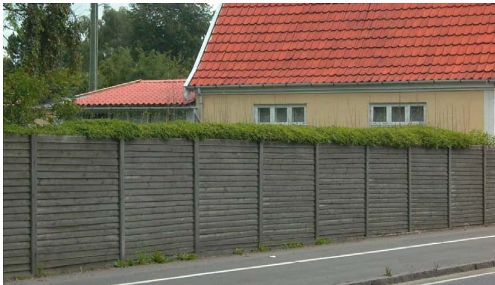
Figur 1.2. Når hegn omkring boliger og friarealer skal bygges eller fornyes af ejeren, kan det besluttes i stedet at opføre det nye hegn således at det samtidig fungerer som en støjskærm ved at anvende den rette design og konstruktion samt velegnede materialer. Det betyder ikke nødvendigvis at prisen stiger markant [10].
