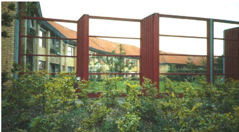
Figur 7.3. Nye lejligheder til ældre hvor en transparent støjskærm er integreret i bygningernes design.
