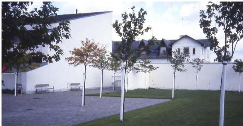
Figur 7.5. Støjskærm i mursten opført som en integreret del af en ny boligbebyggelse.
