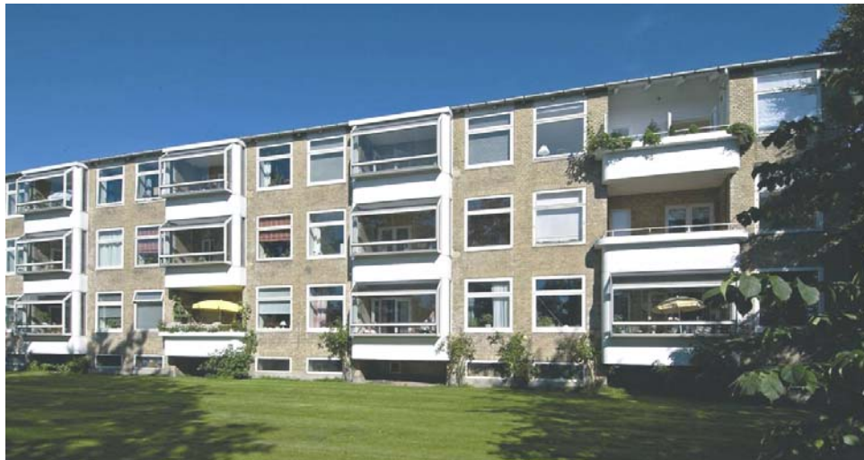
Figur 6.2. Facade isolering mod støj udført på etageboliger langs en overordnet vej.
