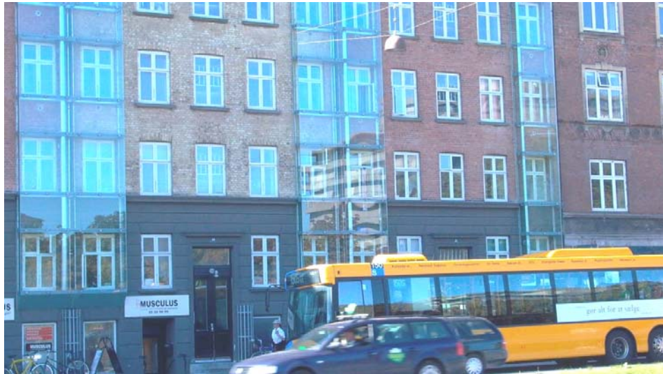
Figur 6.8. Glas er her monteret som støjsolering foran soveværelser og stuer på en etageejendom. Dette tiltag er en del af en byfornyelse af de pågældende ejendomme på Fredensborgvej i København
