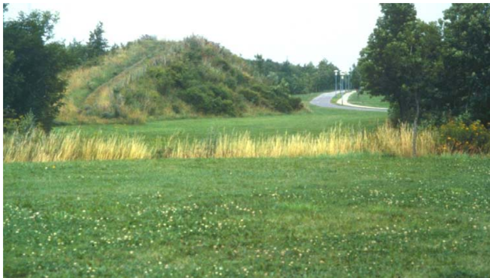
Figur 6.7. Jordvolde her med en sti på toppen og designet til at passe ind i landskabet omkring en motorvej. Jordvolde kan etableres ved brug af overskudsjord fra bygge- og vejprojekter i en region. Der kan evt. udarbejdes en plan for en jordvold, hvor der over en årrække køres overskudsmaterialer til jordvolden således at den etableres over en længere periode. Det kan være vigtigt med en god planlægning af jordvoldens udformning og placering, således at den får en god visuel fremtoning i området.
