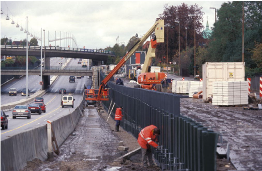
Reparation af spuns- vægge på Helsingør- motorvejen ved Tu- borgvej
