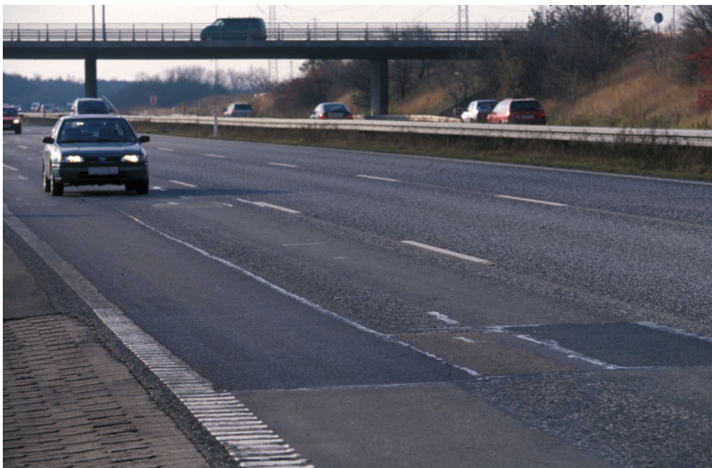
Pletvis reparation af beskadiget vejbelægning på Køge Bugt Motorvejen.
