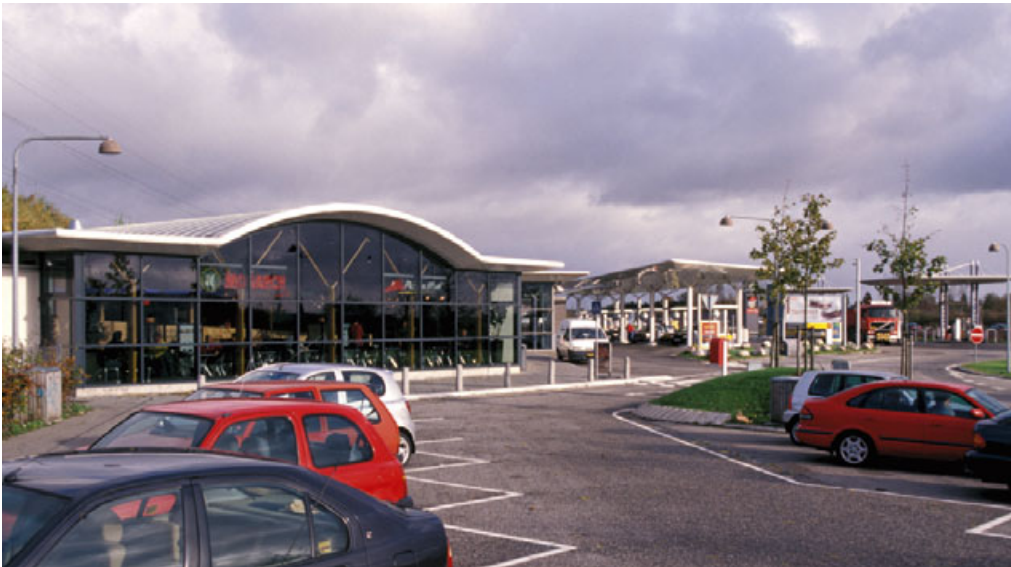
Serviceanlæg ved Karlslunde
