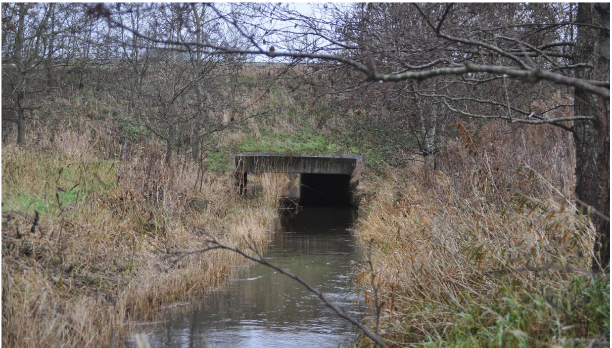
Gremmeløkke Å under Fynske Motorvej.
