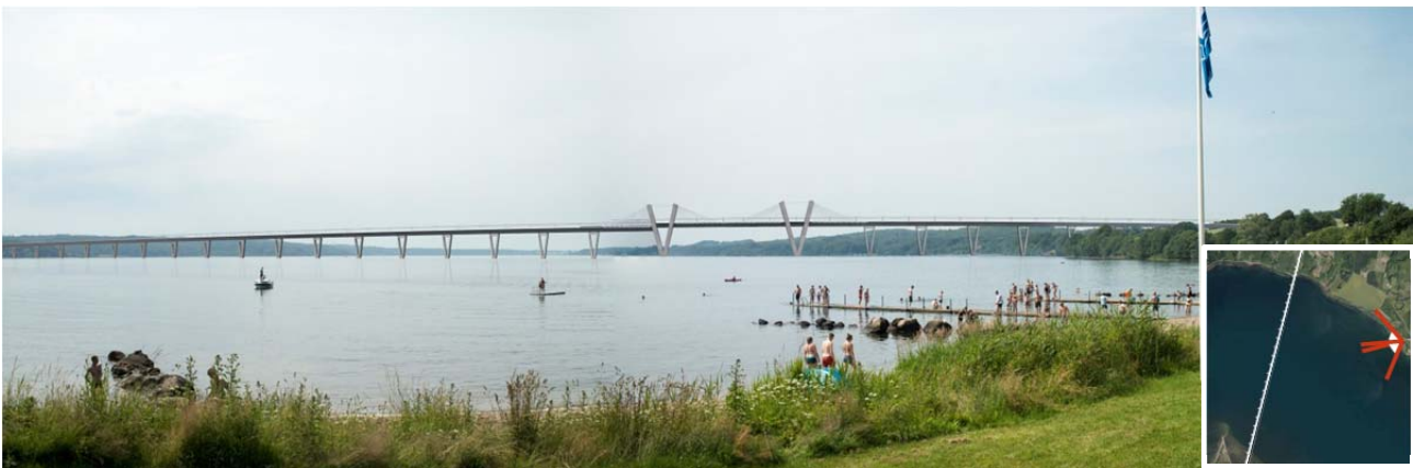
Figur 8-33. Visualisering af linjeføring B (skrånstagsbro) på tværs af Vejle Fjord set fra kysten ved Daugårdstrand (Vejdirektoratet, 2016a).
