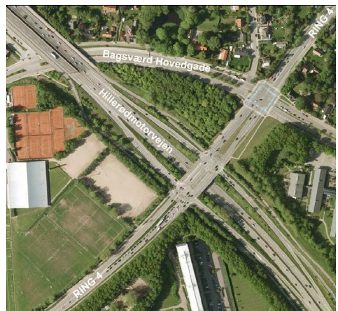
FIGUR 5.3 Ring 4 ved skæringen med Hillerødmotorvejen
