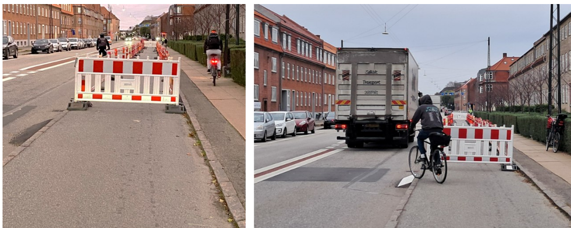
Figur 21. Fotoet til venstre viser overledningen i Forsøg 5 med sort rampe, mens foto til højre viser Forsøg 6 med hvid rampe. I begge forsøg er cykelstien spærret, og cyklister ledes ud på kørebanen for at passere vejarbejdet. Den eneste forskel mellem de to forsøg er rampens farve. (Fotos: Trafitec 2024).
