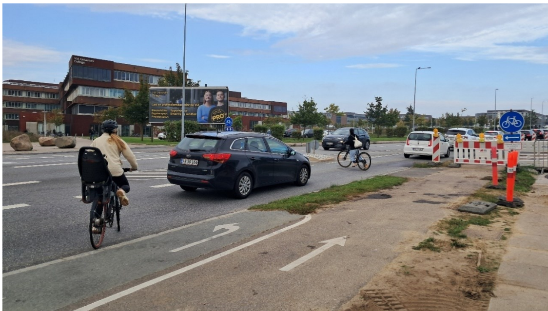
Figur 8. Cyklister der benytter hhv. venstresvingsbane og helleanlæg i forbindelse med overledningen. (Foto: Trafitec 2024).
