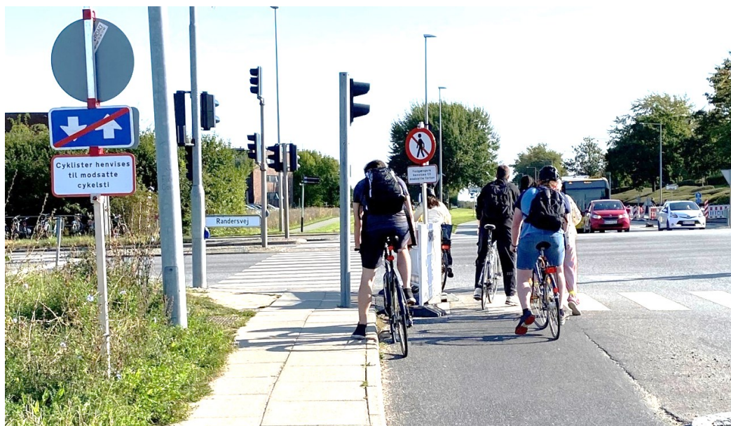
Figur 12. Fotoet viser skiltningen, der markerer ophør af dobbeltrettet cykelsti og henviser til tilbageledning. Tavlerne er placeret kort før det 4-benede kryds, hvor cyklisterne skal tilbage til egen færdselsretning. I krydset ses et andet igangværende vejarbejde. Bemærk cyklister, der efter ophør af dobbeltrettet cykeltrafik, fortsætter med at cykle på stien frem til krydset. (Foto: Trafitec 2024).
