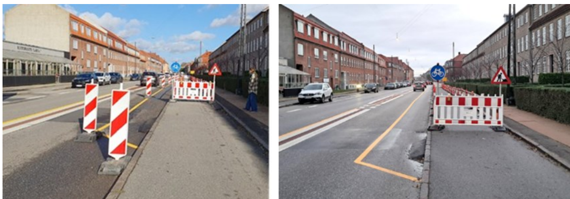
Figur 19. Fotoet til venstre viser overledningen i Forsøg 3, mens foto til højre viser overledningen i Forsøg 4. I begge forsøg er cykelstien spærret, og cyklister ledes ud på kørebanen, hvor de fortsætter forbi vejarbejdet i en midlertidigt afmærket cykelbane. Den eneste forskel mellem de to forsøg er brugen af N 42-tavler i Forsøg 3. (Fotos: Trafitec 2024).
