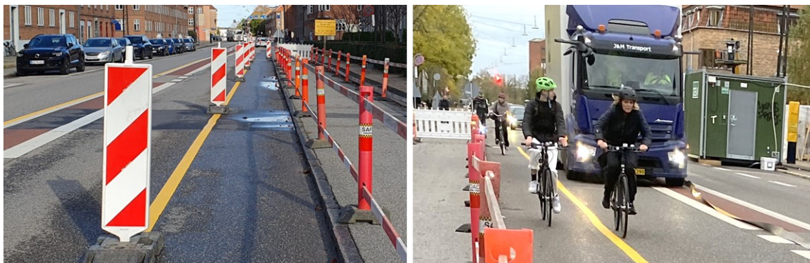
Figur 26. Til venstre Forsøg 3 hvor N 42-tavlerne gør profilet mere smalt og svært for cyklister at overhale. Til højre Forsøg 4 med gul kantlinje. Hovedparten af cyklister holder sig indenfor det afgrænsede areal, men Forsøg 4 - med gul kantlinje - gør det muligt for cyklister at overhale hinanden. (Fotos: Trafitec 2024).
