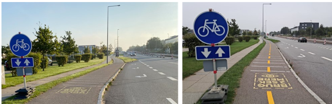
Figur 4. Skiltning af den midlertidige dobbeltrettede cykelsti. Til venstre ses Forsøg 1 uden delelinje mellem de to kørselsretninger. Til højre ses Forsøg 2 med en gul delelinje, der tydeligt adskiller retningerne. (Fotos: Trafitec 2024).
