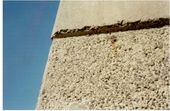
Overfladeforvitring/erosion (Vejlefjordbroen)
