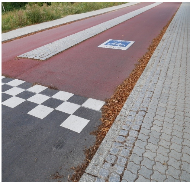
Figur 5.2: Til højre cykelgade med rød asfalt (Holbæk). Til venstre cykelgade med granitvulst og brolægning (København). (Fotos: Rambøll, 2023 og 2024).
