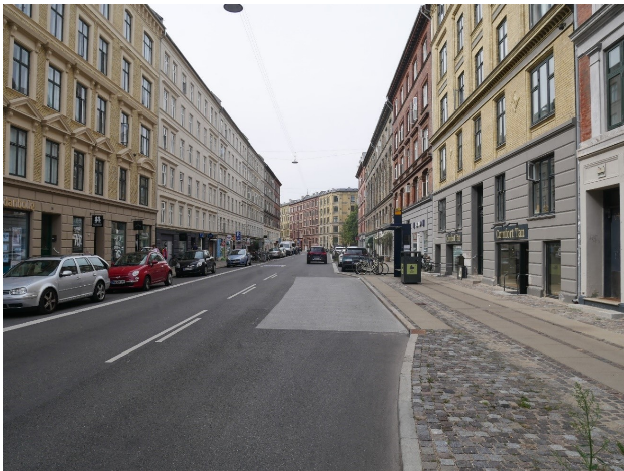
Figur 5.11: Busstoppested i Nordre Frihavnsgade. Busstoppestedet er beliggende i en halv buslomme, hvor cyklister kan overhale en holdende bus uden at komme over i modgående kørebane. (Foto: Rambøll, 2024).
