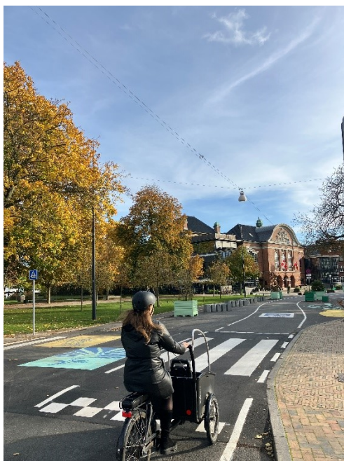
Figur 5.5: Til højre Jernbanegade, ensrettet cykelgade i Odense med hævet flade og fodgængerovergang. Til venstre modstrømscykelsti i venstre side. (Fotos: Odense Kommune, 2024).
