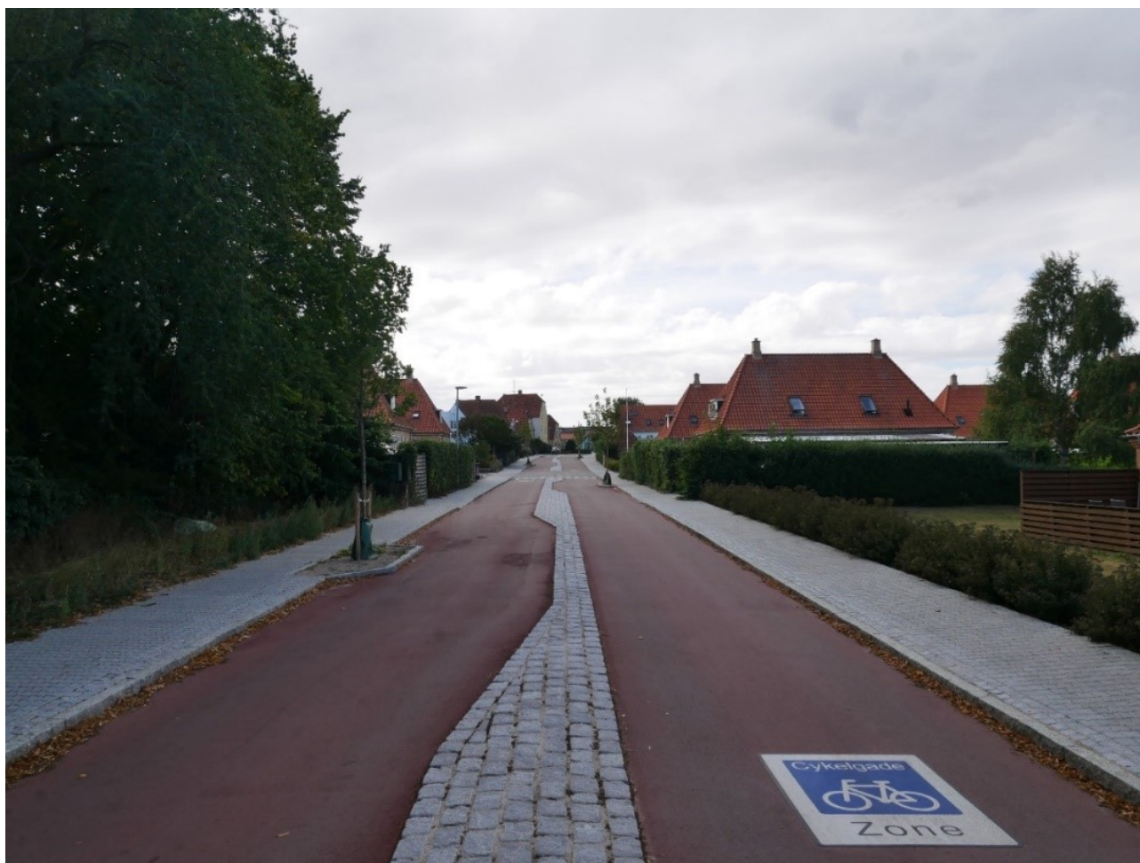
Figur 5.10: Højen med den karakteristiske røde belægning og midtervulst. (Foto: Rambøll, 2023).
