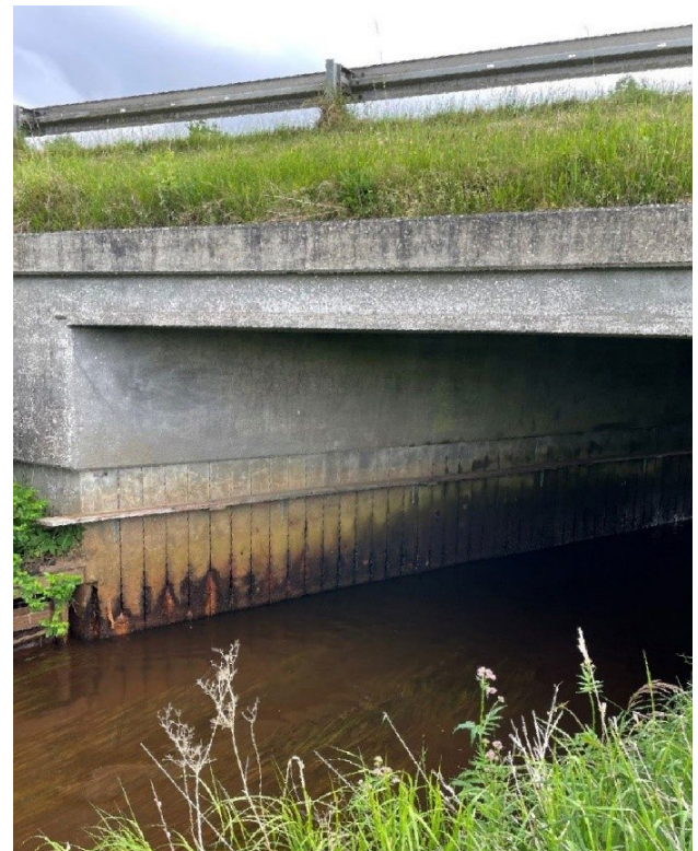
Den eksisterende bro ved Alslev Å
