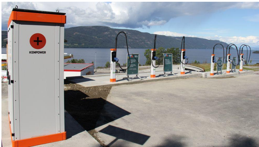
Figur 11.6 Ladestanderne foran køretøjerne. Eksempel fra rasteplass i Norge. Foto: Kempower
