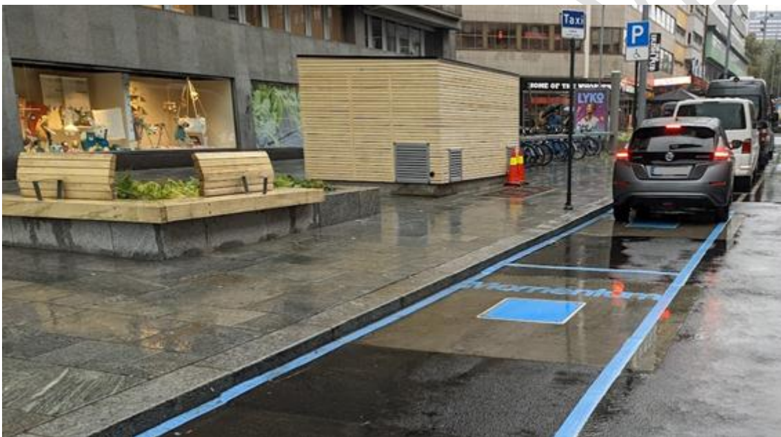
Figur 12.3 Induktiv ladning for taxaer i Oslo, Norge. I baggrunden ses det træbeklædte skur med power modulet. Som det fremgår, er skuret relativt pladskrævende i bybilledet. Foto: Rambøll Norge
