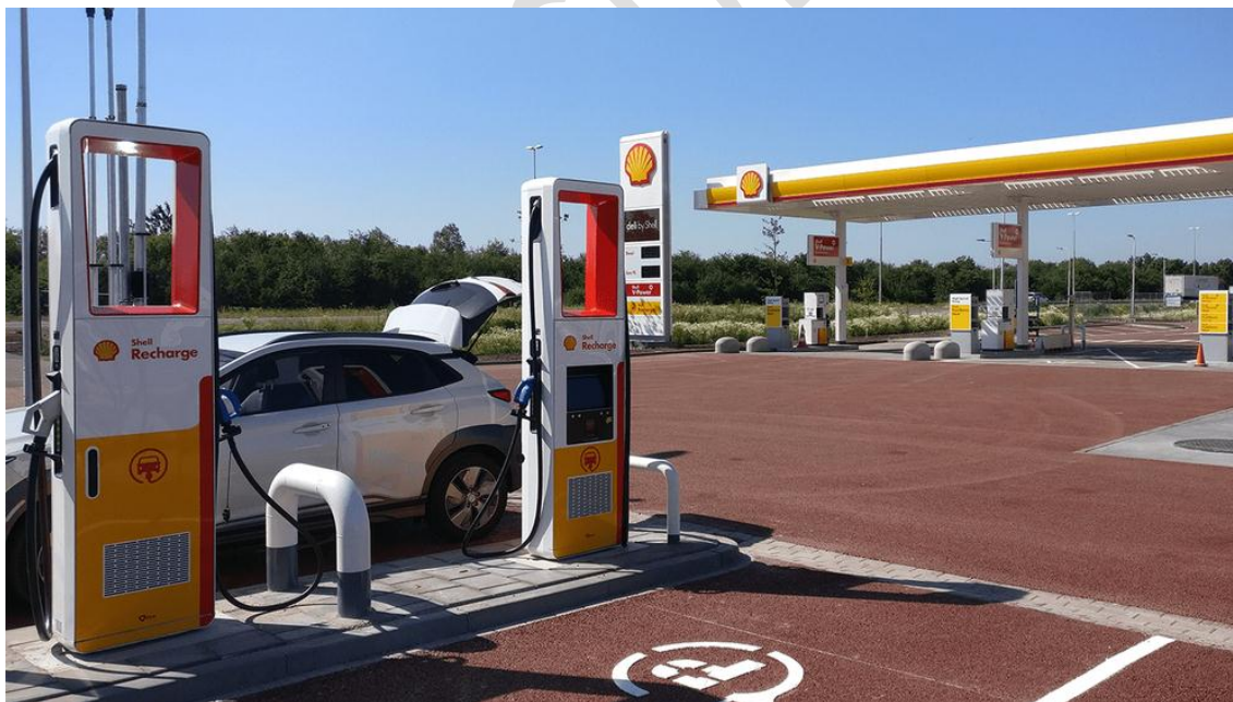
Figur 11.7 Ladestanderne på siden af køretøjerne. Eksempel fra rasteplass i Norge. Foto: Shell
