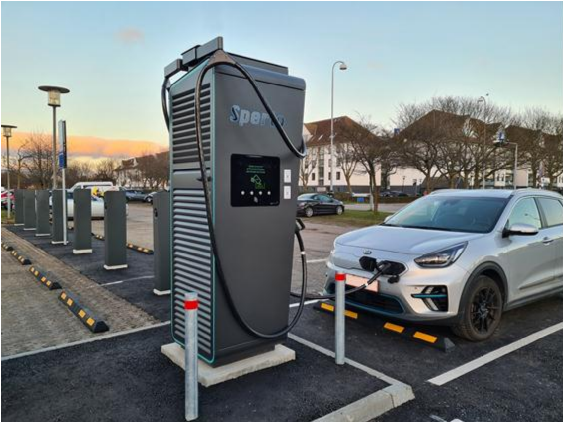
Figur 12.2 Sperto ladehub i Ishøj, som har en 150 kW lynlader og syv normalladere. Ladestanderne deler samme nettilslutning opsat i lastbalancering/load management. Delingen af nettilslutningen bidrager til såvel økonomisk som miljømæssig bæredygtighed i projektet. Normalladerne benyttes primært om natten og lynladning primært om dagen. Foto: Sperto ApS.
