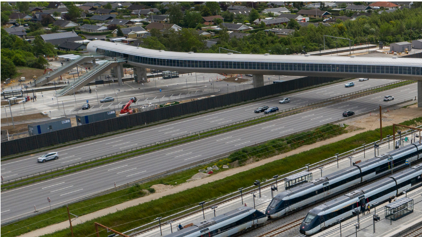
Køge Nord station ved Køge Bugt Motorvejen. Foto: Bjarke Ørsted/Ritzau Scanpix
