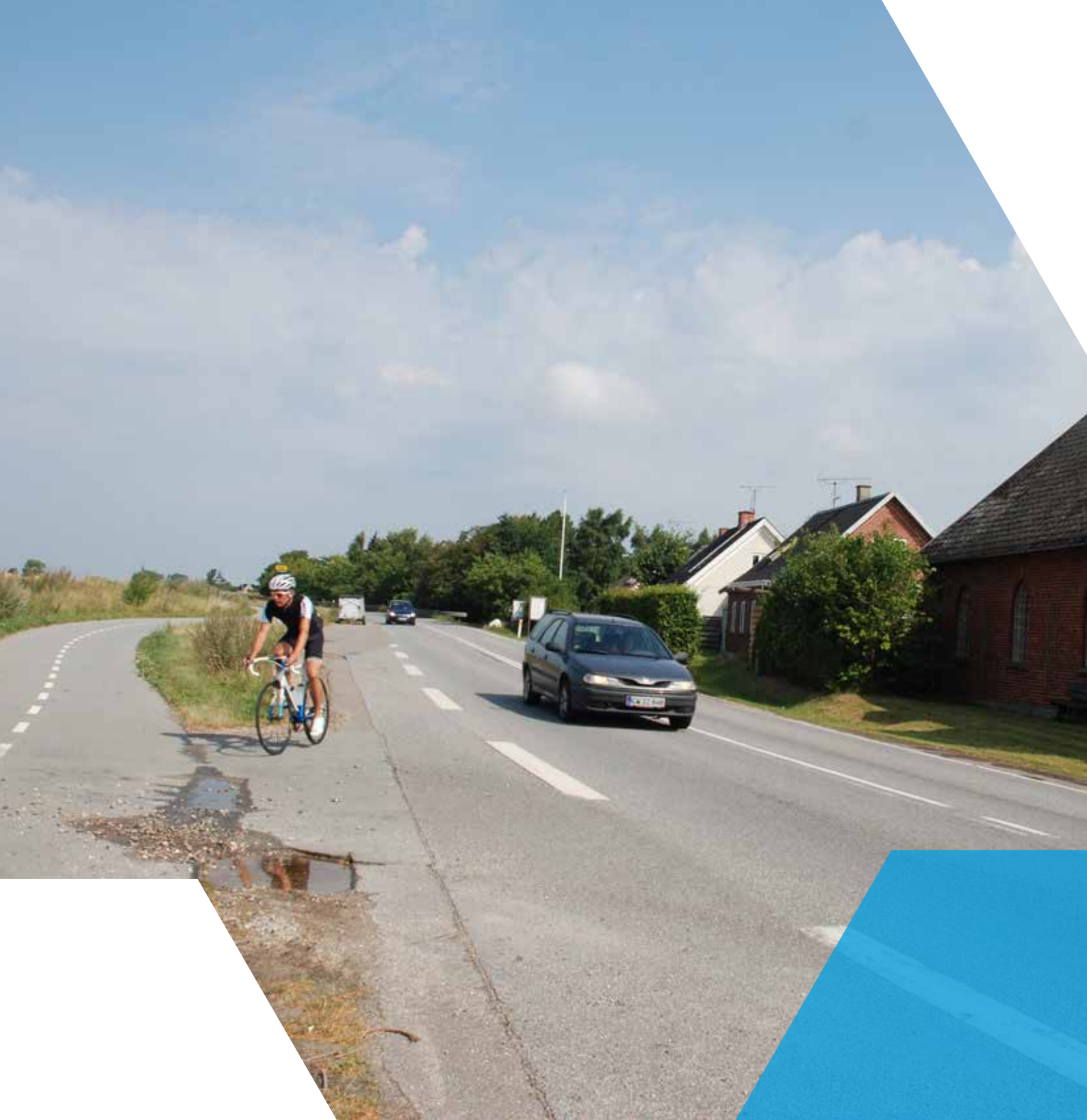
FIGUR 10 Pårupvej set mod nord
