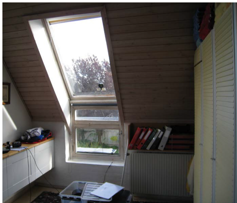
FIGUR 34 Velux-vinduet og vinduet i ydervæggen udgør et integreret parti.
