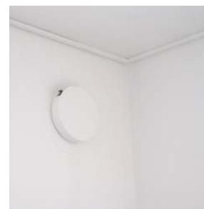
FIGUR 28 Lydisolerende friskluftventil af fabrikat Lindab type ULA med lydsluse
