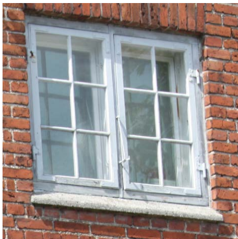
FIGUR 12 Ældre vindue med forsatsvindue
