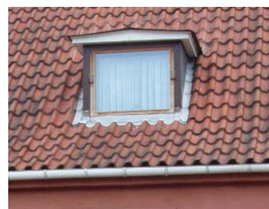
FIGUR 22 Denne løsning benyttes oftest, når der er tale om udskiftning af et helt facadeparti, hvor vinduer og brystning er integreret. En særlig kategori lette vægge udgøres af kvistflunker, som ofte er bygget op af 2 lag brædder med ringe. Foranstaltningerne er som for de øvrige lette vægge, men ofte vælges det at udskifte hele kvisten, fordi den er i dårlig stand, og fordi kvisttaget ofte er dårligt isoleret.
