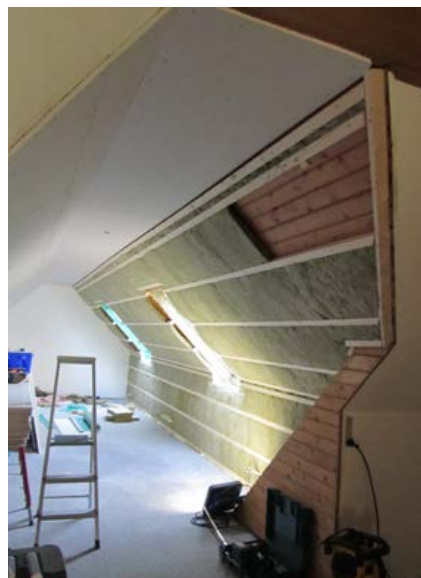
FIGUR 45 Billede fra isoleringsarbejdet, hvor den indvendige supplerende beklædning er ved at blive etableret.
