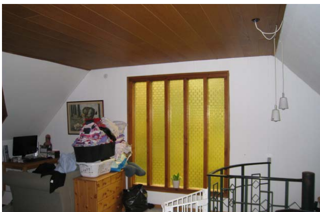
FIGUR 43 Rummet har et stort vindue med termorude monteret i en let gavl.
