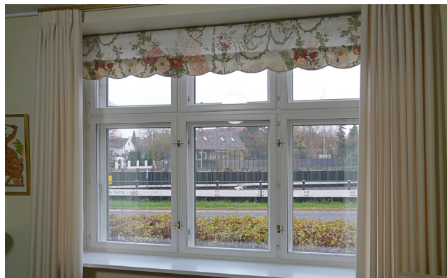
FIGUR 37 De nye vinduer er forsynet med termolydruder både i ydervindue og forsatsvindue
