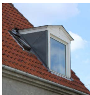
FIGUR 22 Denne løsning benyttes oftest, når der er tale om udskiftning af et helt facadeparti, hvor vinduer og brystning er integreret. En særlig kategori lette vægge udgøres af kvistflunker, som ofte er bygget op af 2 lag brædder med ringe. Foranstaltningerne er som for de øvrige lette vægge, men ofte vælges det at udskifte hele kvisten, fordi den er i dårlig stand, og fordi kvisttaget ofte er dårligt isoleret.
