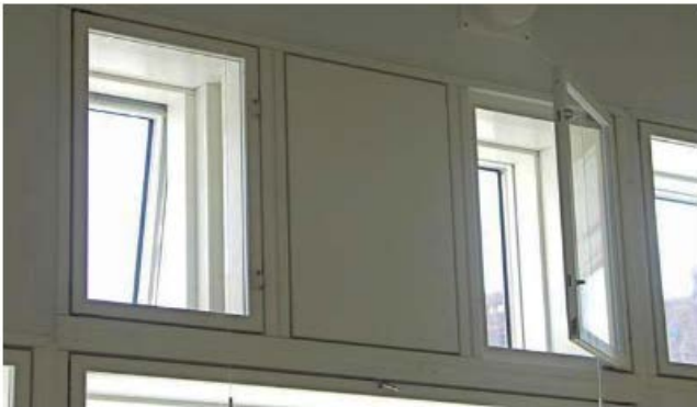
FIGUR 16 En variant af "russervinduet" findes på Bikuben Kollegiet i København, hvor der er indbygget en lydsluse i væggen mellem de to vinduer. Ved at åbne kombinationerne A-D eller B-C fås frisk luft gennem en lydsluse.
