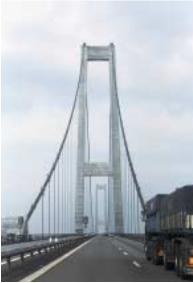
Storebæltsbroen med sine imponerende pyloner er et eksempel på ufattelig skala: Vi føler os meget små, men også trygge ved at færdes midt i Storebælt på en bro, der nok skal holde.
