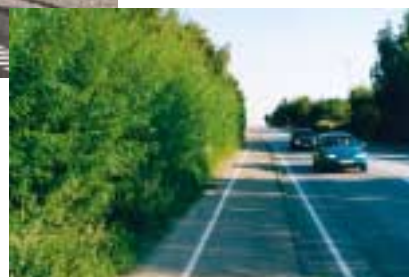
Støjskærme kan også udføres af levende pilehegn, med en støjabsorberende kerne i midten.
