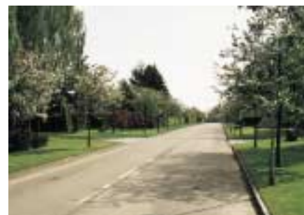
Skalasalmenhæng mellem vejens geometri og dens forskellige elementer er opnået på denne villavej i Ikast.
