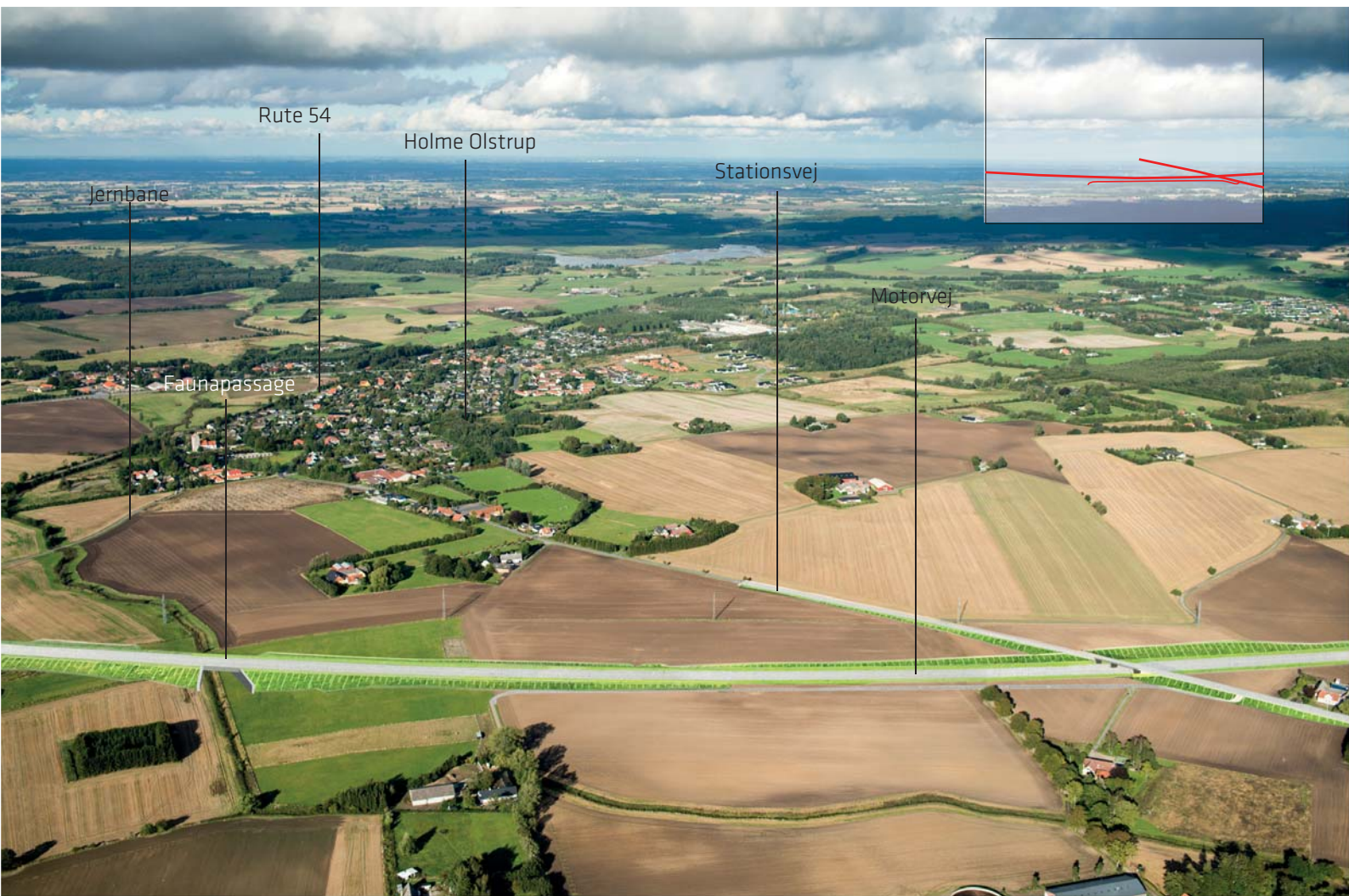
Fig. 28 - Motorvejen skifter mellem at løbe på dæmning og i afgravning. Stationsvej krydser motorvejen på en bro.
