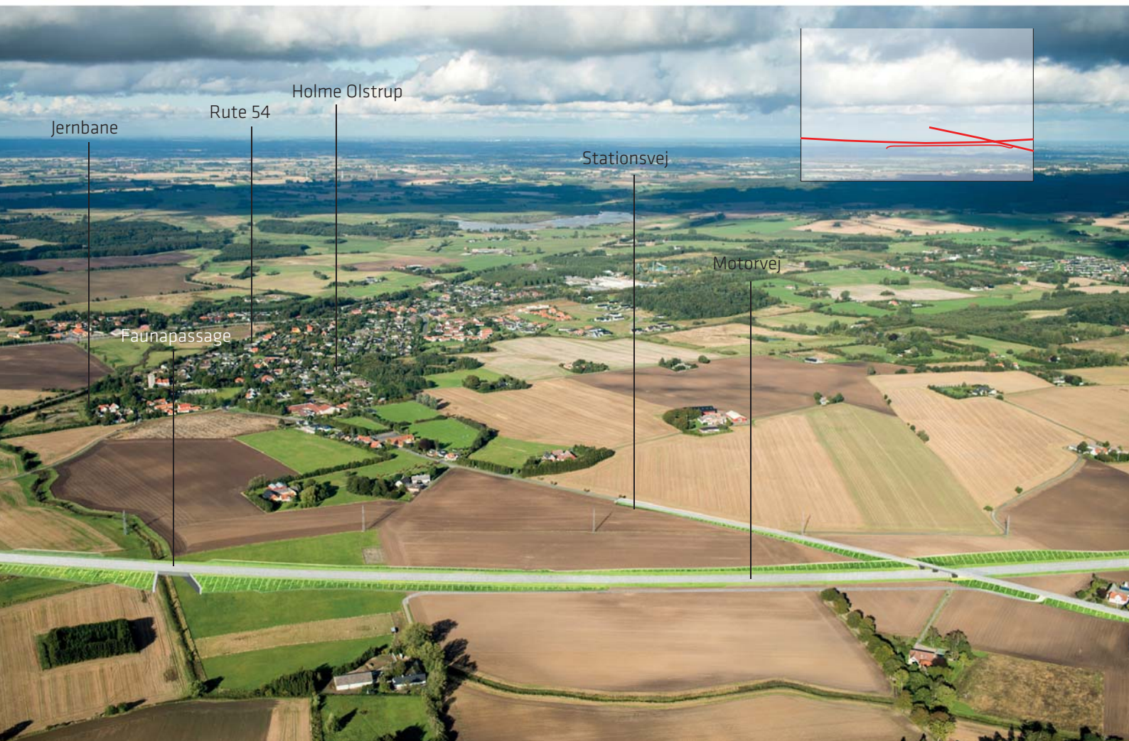
Fig. 34 - Motorvejen skifter mellem at løbe på dæmning og i afgravning. Stationsvej krydser motorvejen på en bro.
