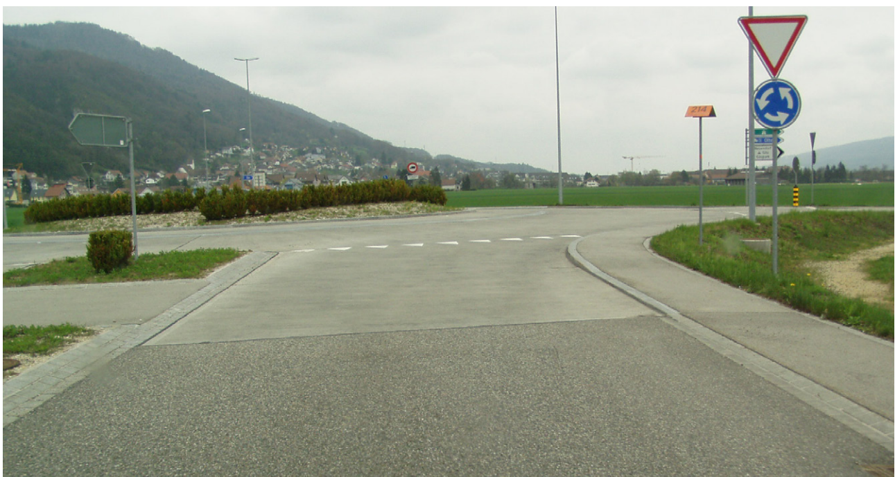
Figur 2.4: Der anvendes betonbelægninger i nogle rundkørsler i Zürich- området, da denne belægningstype er meget modstandsdygtig over for drejende trafik.
