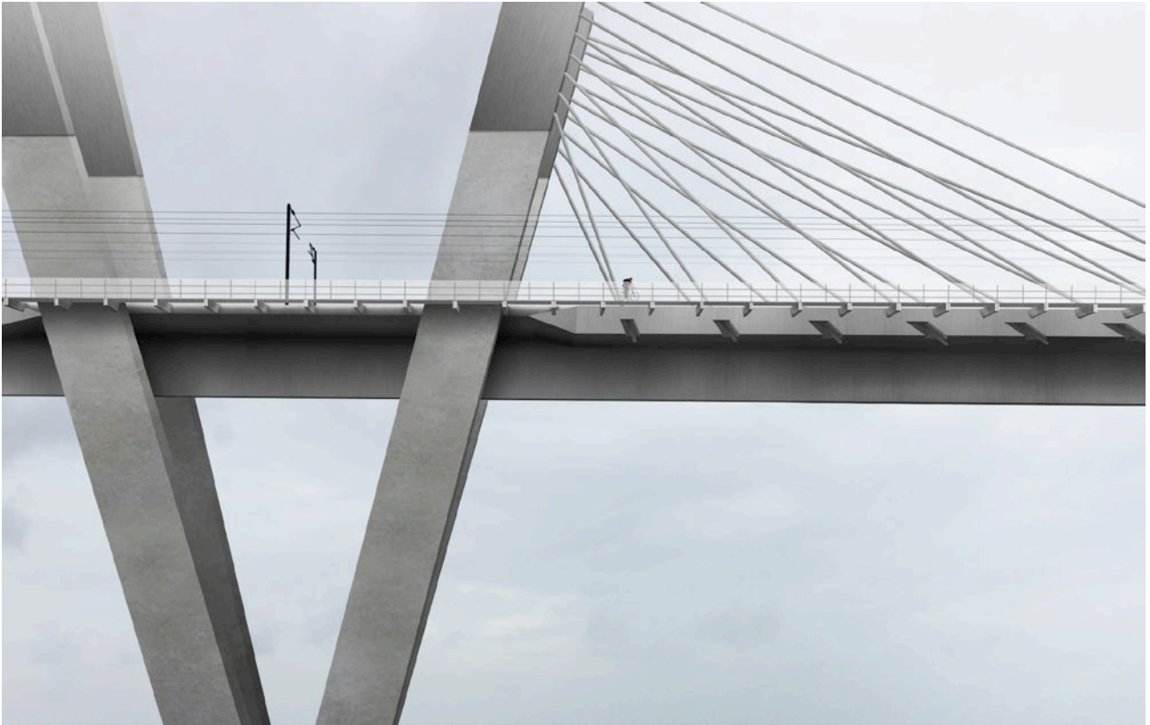
Skråstagsbroen med cykelsti
