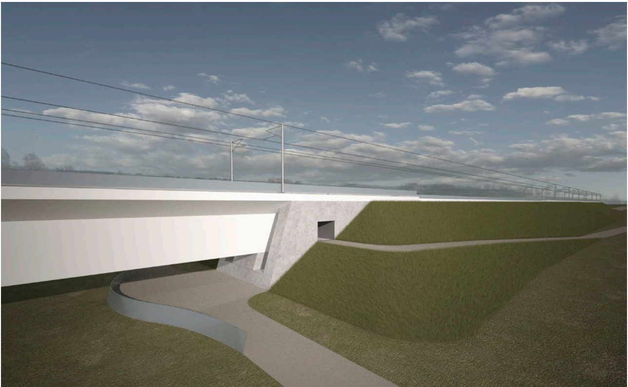
Eksempel på udformning af landfæstet
