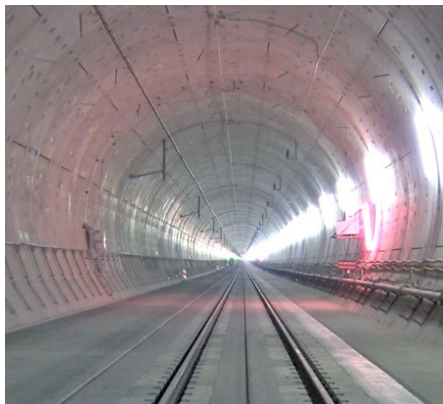
I tunnelen placeres skinnerne som "slab track" (på en betonplade)
