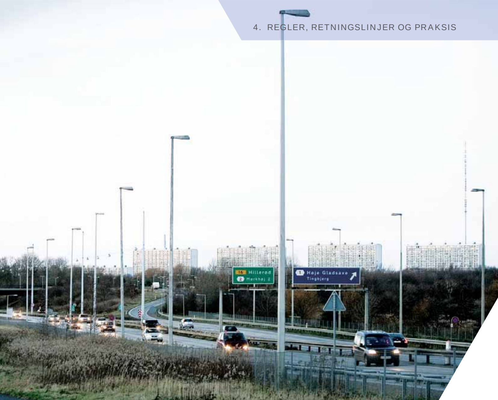
Billede 4-3 Eksempel på ældre anlæg med firkantkoniske master og ombyggede armaturer. (Hillerød motorvejen ved Høje Gladsaxe).
