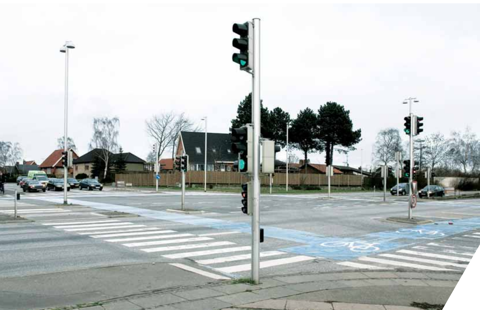
Billede 6-6 Ved signalregulerede kryds anvendes typisk kombimaster for signalanlæg og belysning (Ballerup Byvej).
