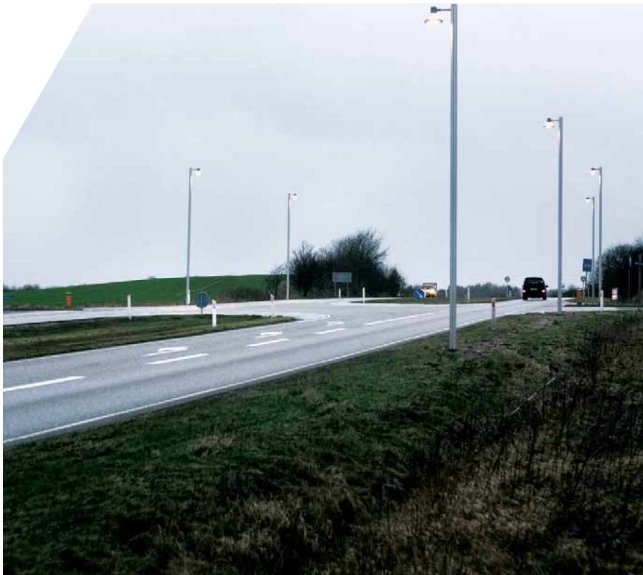
Billede 3-4 Belysning af kryds på en i øvrigt ubelyst motortrafikvej. Belysningsanlægget medvirker til at gøre trafikanten opmærksom på krydset både i mørke og dagslys. (Skovvejen ved Vipperød)
