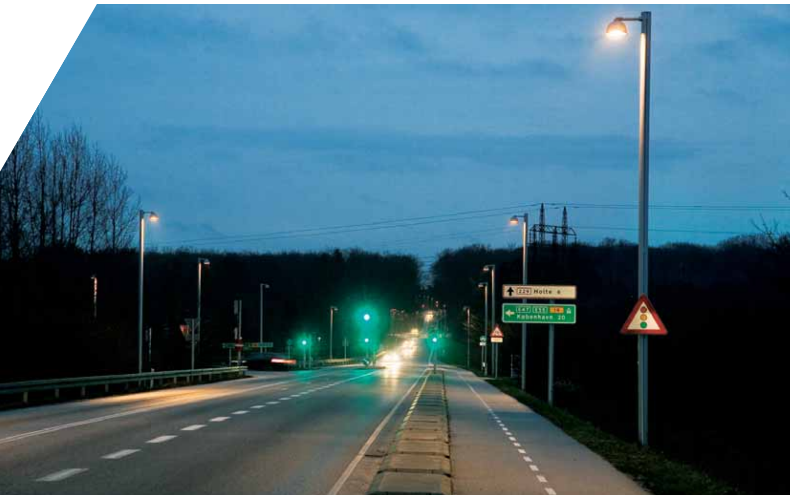
Billede 3-8 Signalregulerede kryds belyses altid. (Hørsholm Kongevej ved Helsingørmotorvejen)
