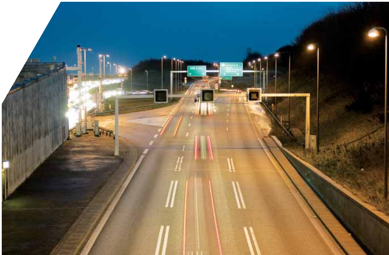
Billede 3-2 Kompliceret udfletningsanlæg med mange indtryk langs vejen og mange informationer til trafikanten (Kridtsvinget ved Limfjordstunnelen).
