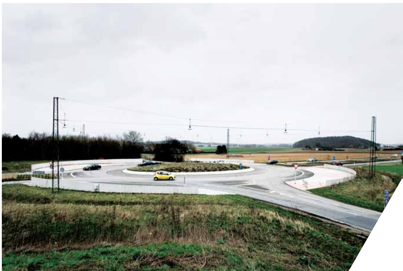
Billede 6-8 Forsøgsprojekt med en alternativ udformning af belysningen i en rundkørsel (Skovvejen/Cementvej).
