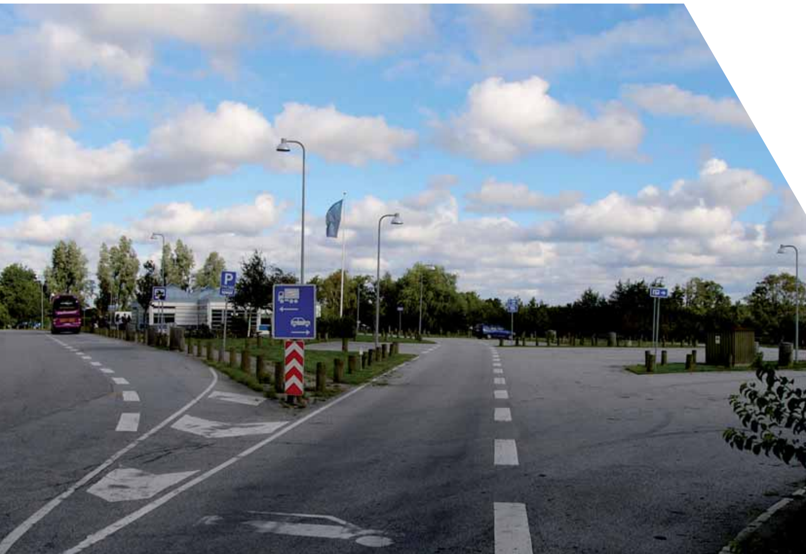
Billede 3-14 Rastepladser ligger ofte afsides og belysning kan øge trygheden og komforten for pladsens brugere. (Himmerland rasteplads langs E45).
