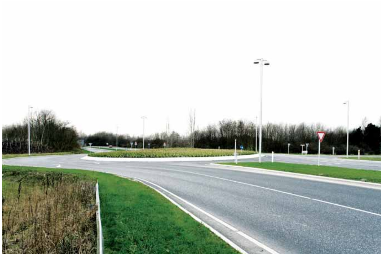
Billede 6-7 Enkelt belysningsanlæg i en mindre rundkørsel. Master er placeret dels ved ydersiden og dels i den brede midterrabat, som "ender" ved rundkørslen. (Frederikssundsvej ved Udlejrevej, Ølstykke)
