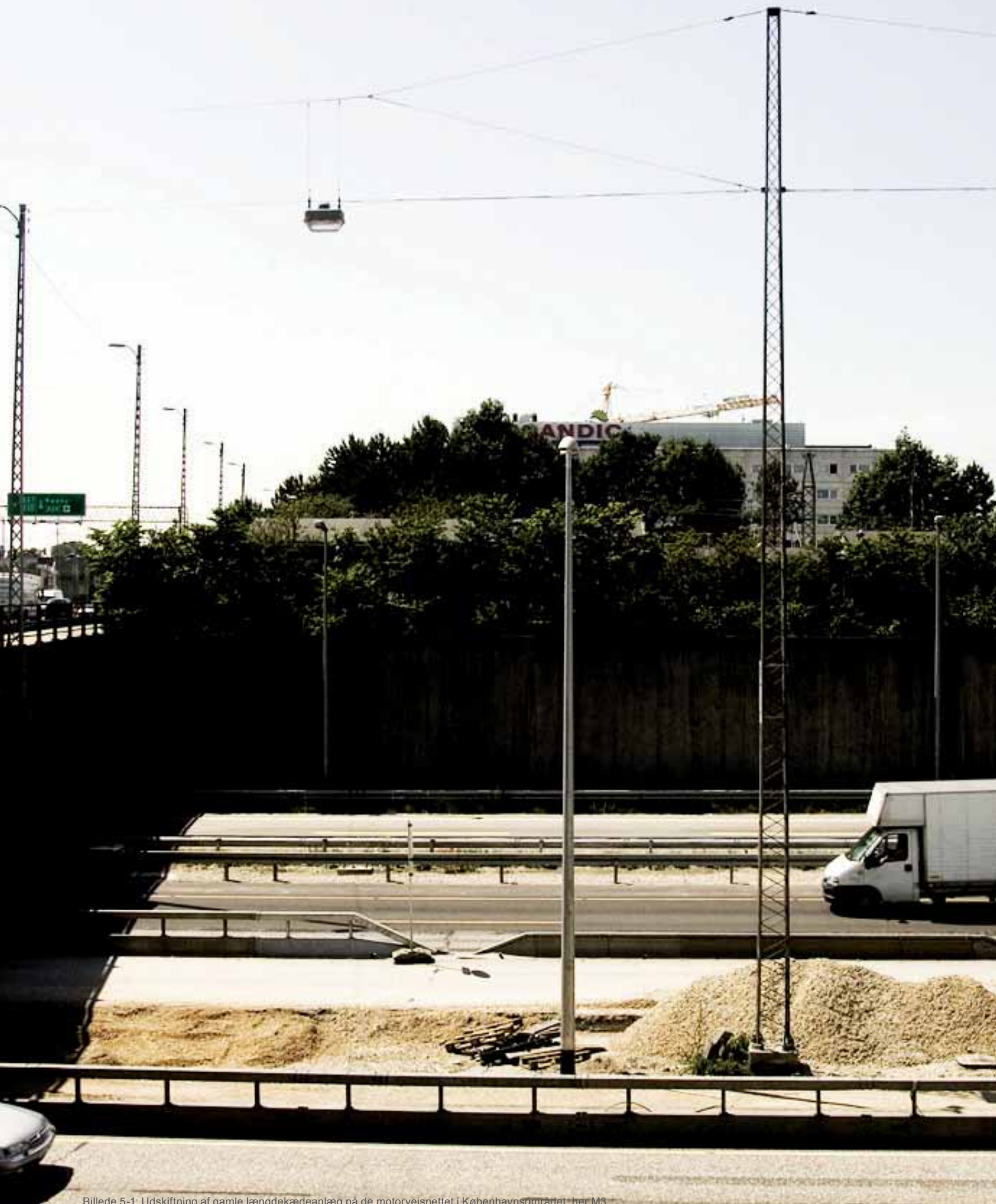
Billede 5-1: Udskiftning af gamle længdekædeanlæg på de motorvejsnettet i Københavnsområdet, her M3.
