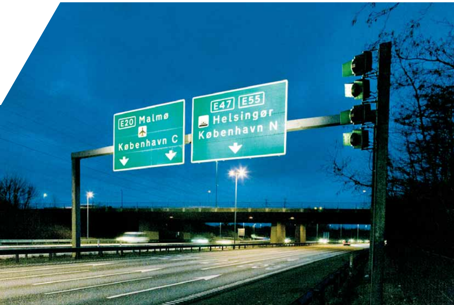
Billede 3-17 Portaltavler belyst vha. projektører i siderabatten (Køge Bugt Motorvejen ved Brøndbyvester Boulevard).
