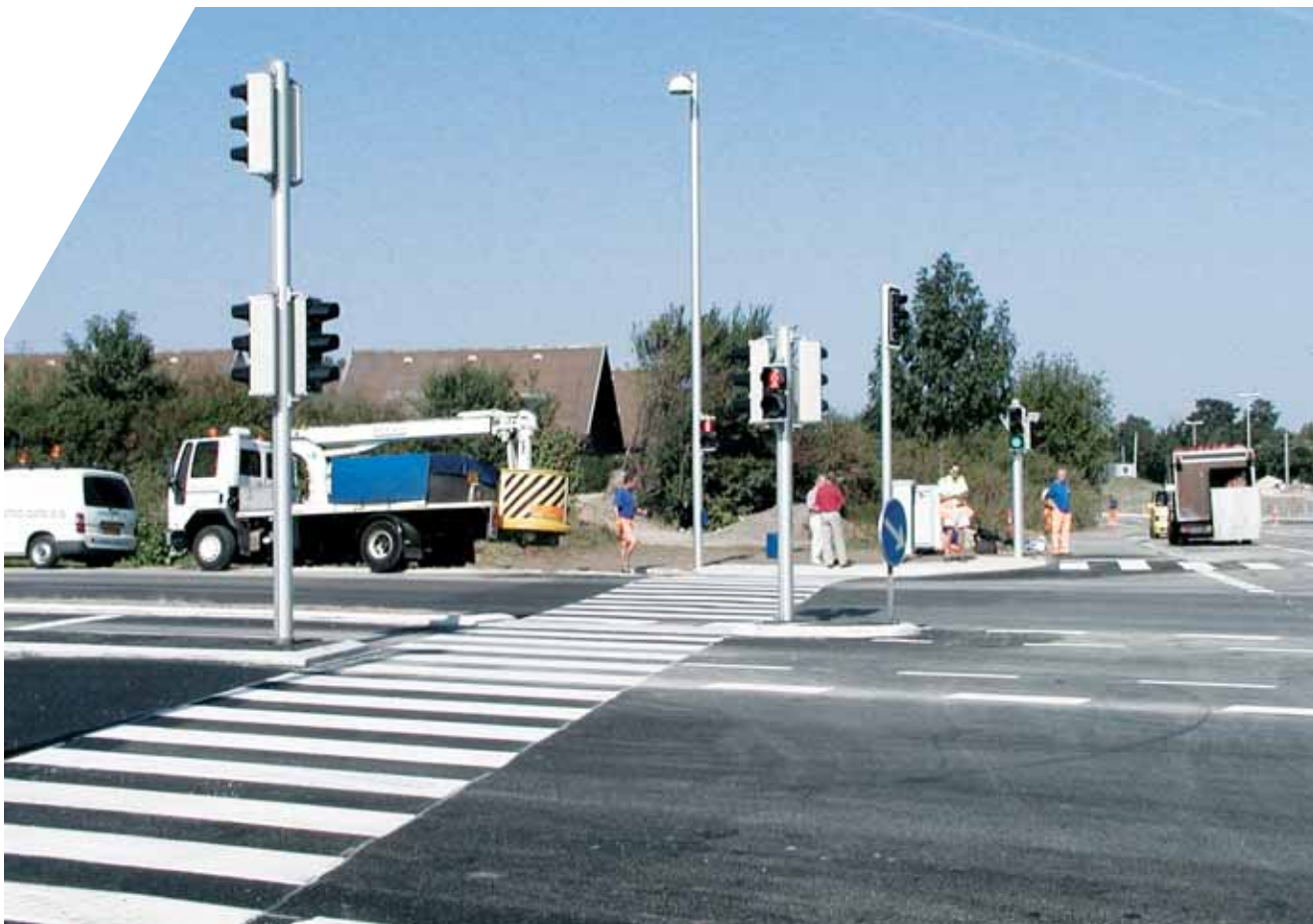
Billede 6-10 Ved at placere master korrekt kan fodgængerfeltet belyses som en del af den samlede krydsbelysning (Ølstykke).
