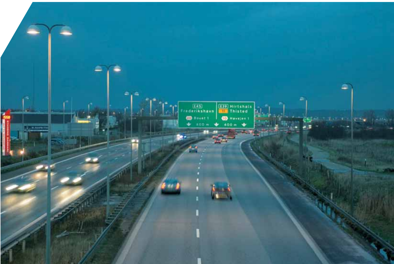
Billede 4-7 Københavnerarmatur med plan skærm placeret i midterrabat. (E45 ved Ålborg).
