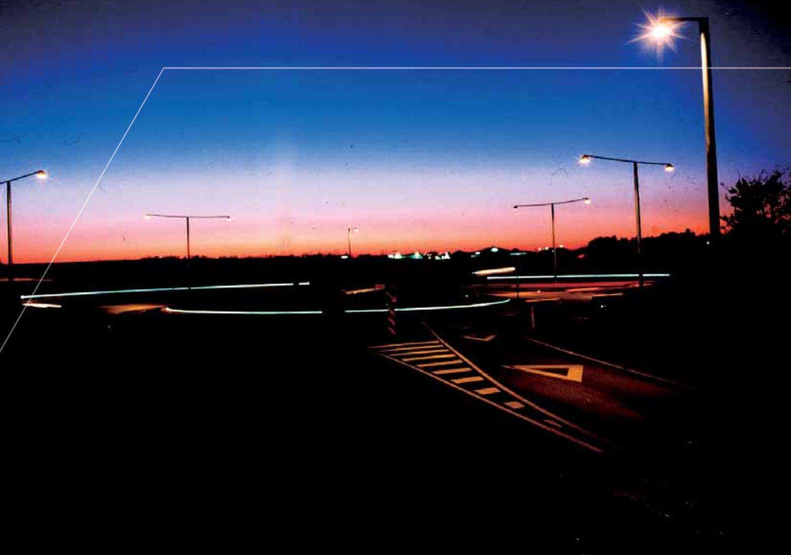
Billede 7-2 Rundkørsel med sidelysende fiber i kanten af midterøen og langs en lav mur i yderkanten (Frederikssund/Strandvangen i Frederikssund).
