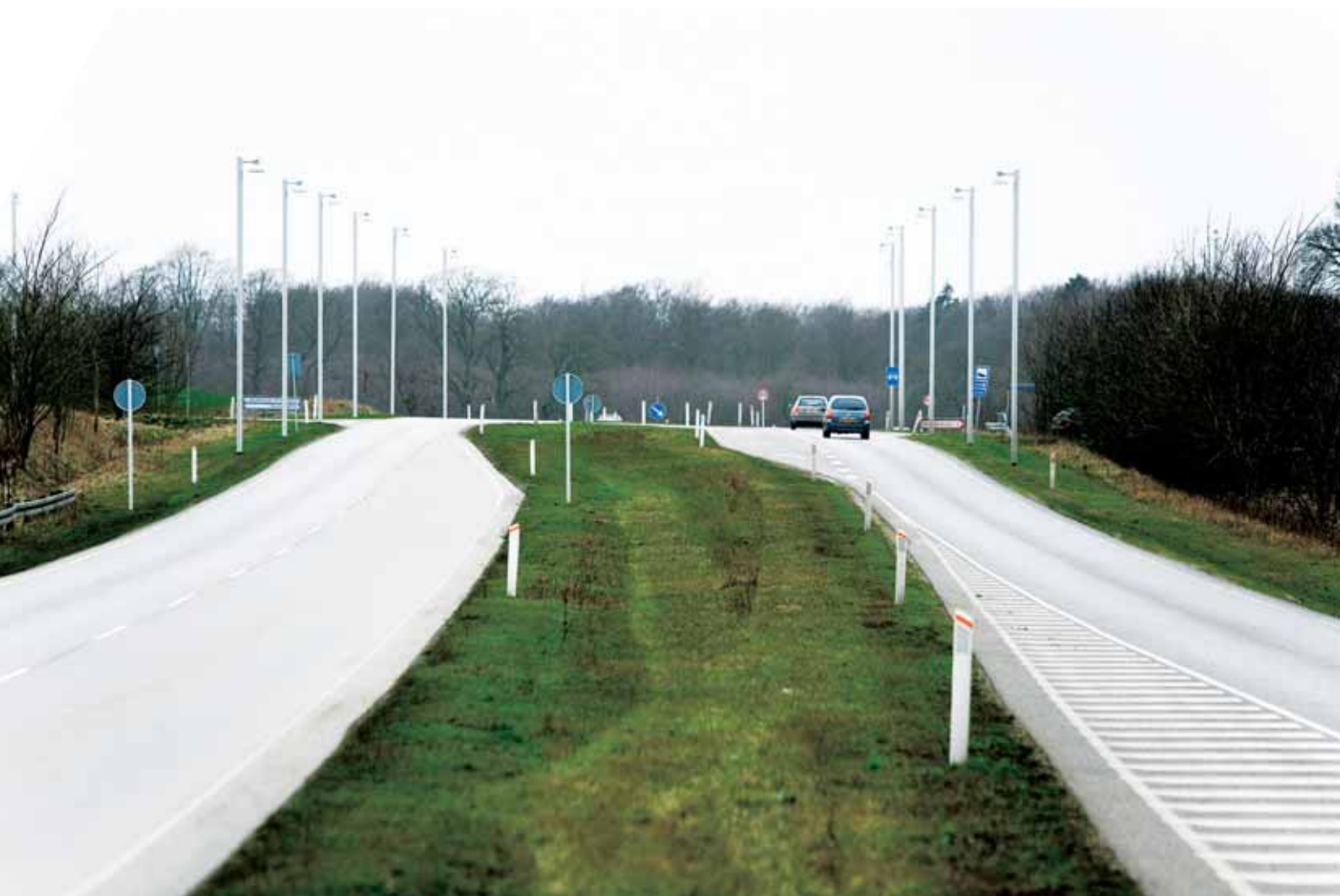
Billede 6-2 Krydsbelysning som på enkel vis signalerer at her sker noget. (Skovvejen ved Knabstrup).
