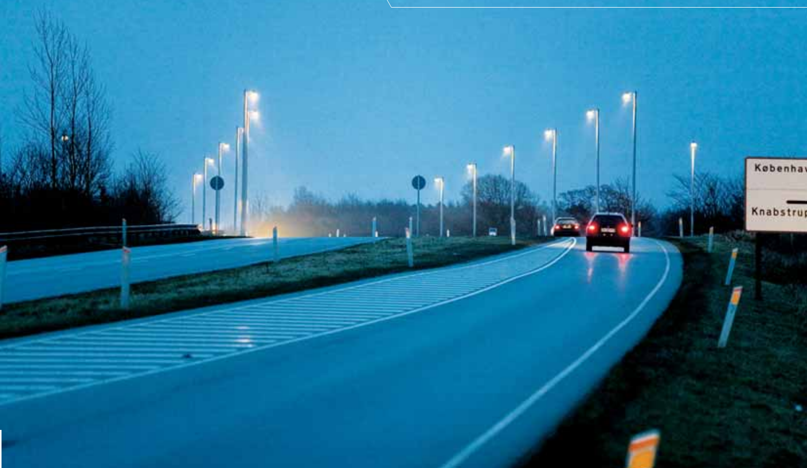
Billede 6-3 Belysningen bidrager væsentligt til at gøre opmærksom på krydset som ellers knapt anes pga. vejens krumning. (Skovvejen ved Knabstrup).
