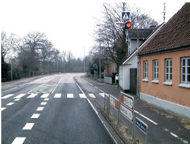
Billede 6-9 Kombineret Torontoanlæg og belysning af fodgængerfelt på en lige strækning. (Vej133 igennem Stokkemærke på Lolland).
