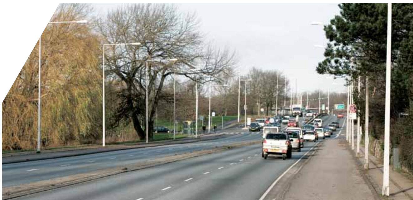
Billede 4-5 Eksempel på anlæg med lange mastearme (Hareskovvejen ved Brønshøj).
