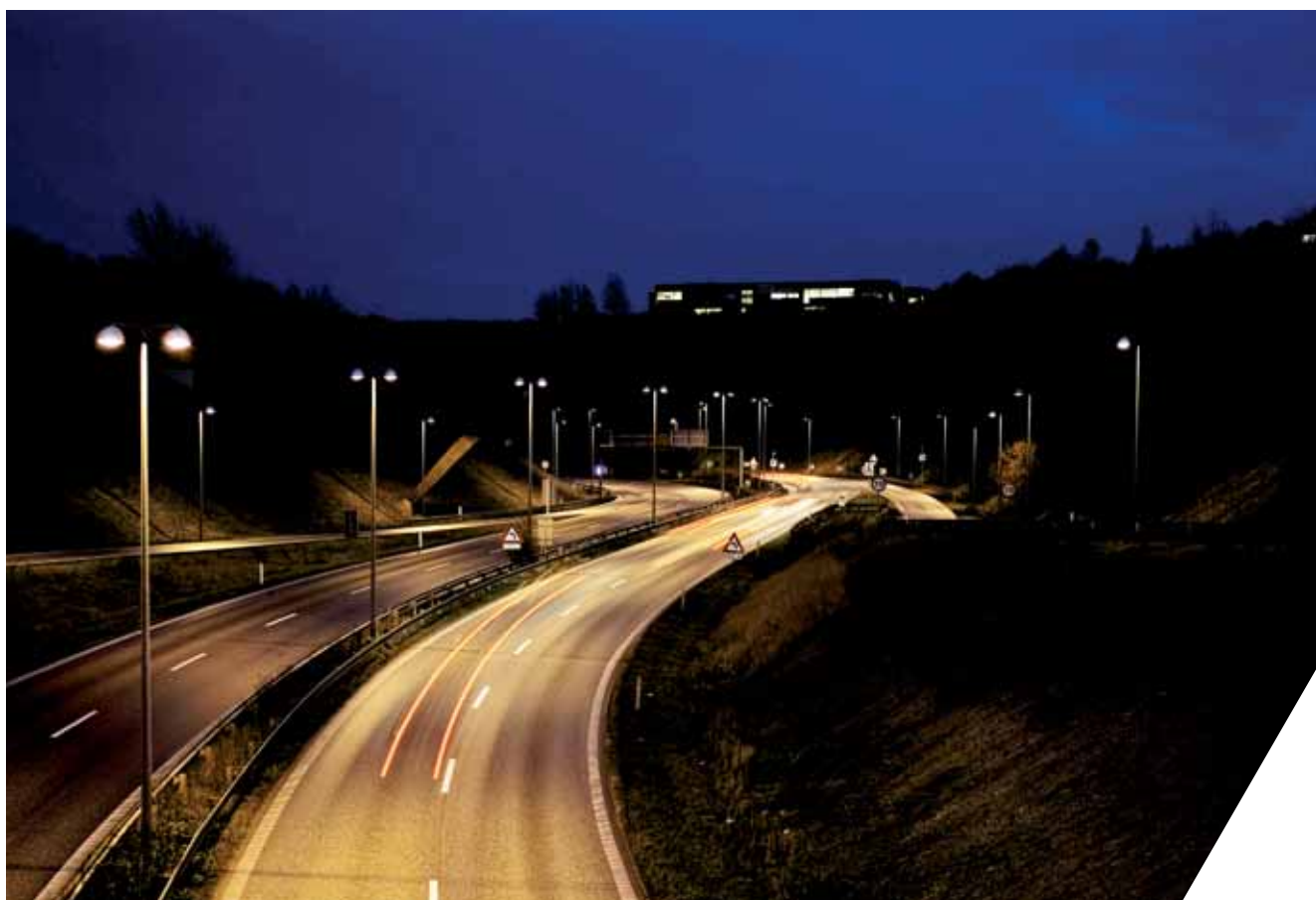
Billede 2-1 Belysningsanlægget skal være i harmoni med omgivelserne både ved dag og nat.(E45 ved Aalborg).
