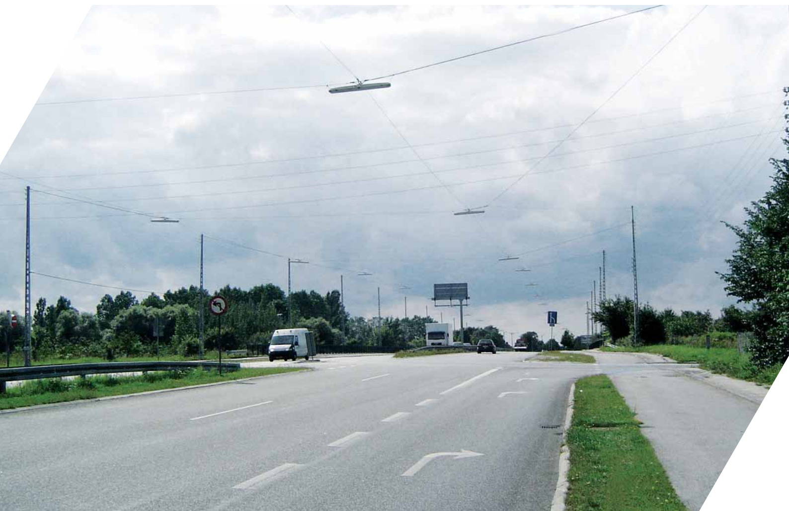
Billede 4-1 Belysningsanlæg med lysstofrørsarmaturer ophængt i wirer på gittermaster. Alder ukendt. (Gl. Køge Landevej/Amagermotorvejen, ikke en statsvej).
