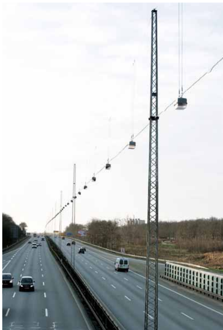
Billede 4-4 Længdekædeanlæg på de københavnske motorveje med forskellige armatur- og mastetyper. (Helsingørmotorvejen).
