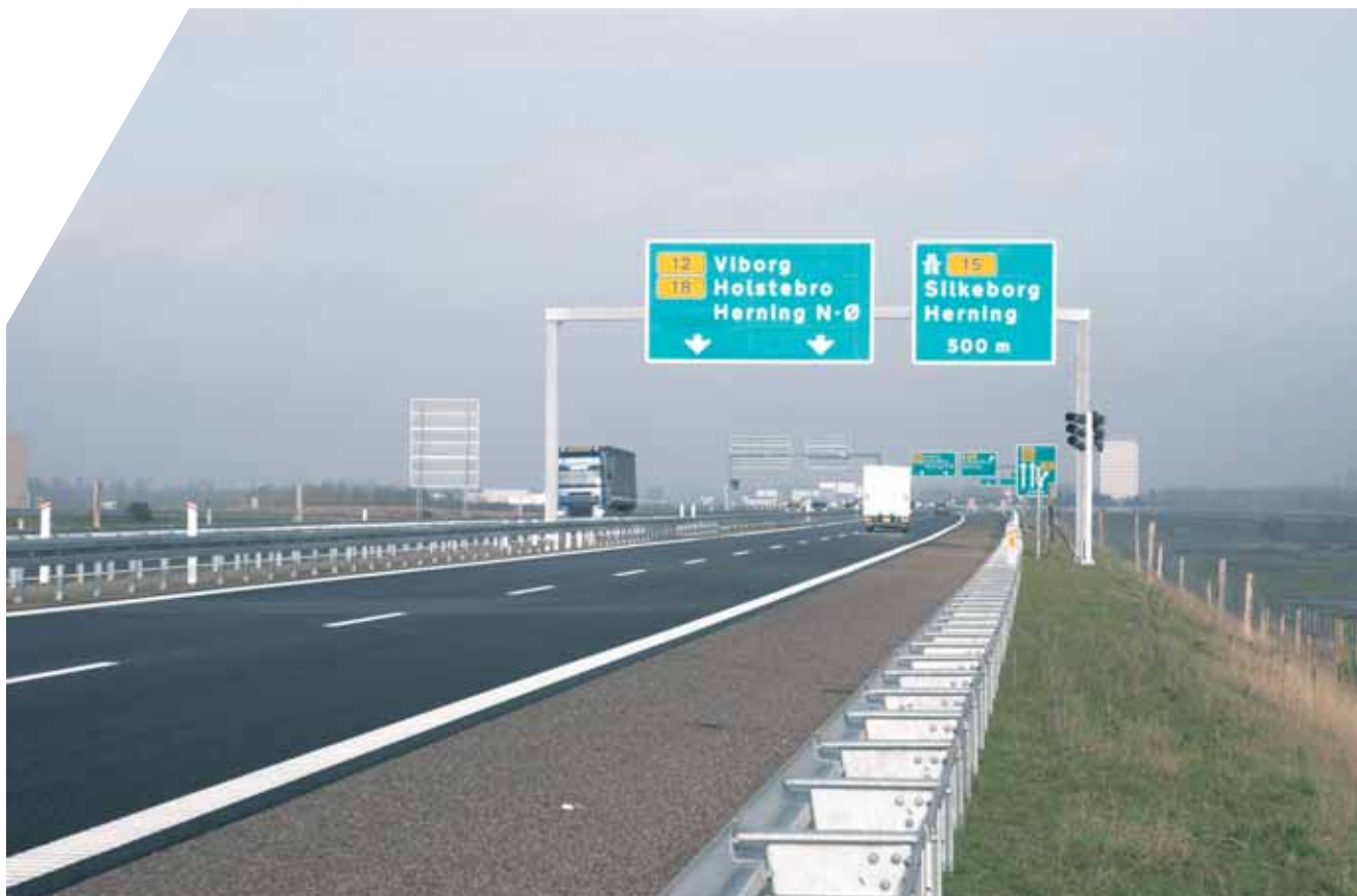
Billede 6-16a Portaltavler med projektørstander i siderabatten bestykket med 6 projektører
