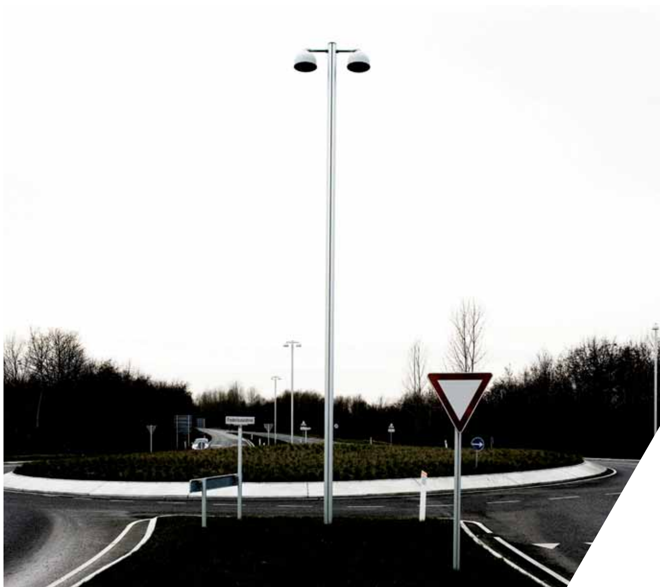
Billede 3-5 Belyst rundkørsel på motortrafikvej. Belysningsanlægget øger trafikantens opmærksomhed og mindsker risikoen for at rundkørslen "overses". (Frederikssundsvej/Udlejrevej i Ølstykke)
