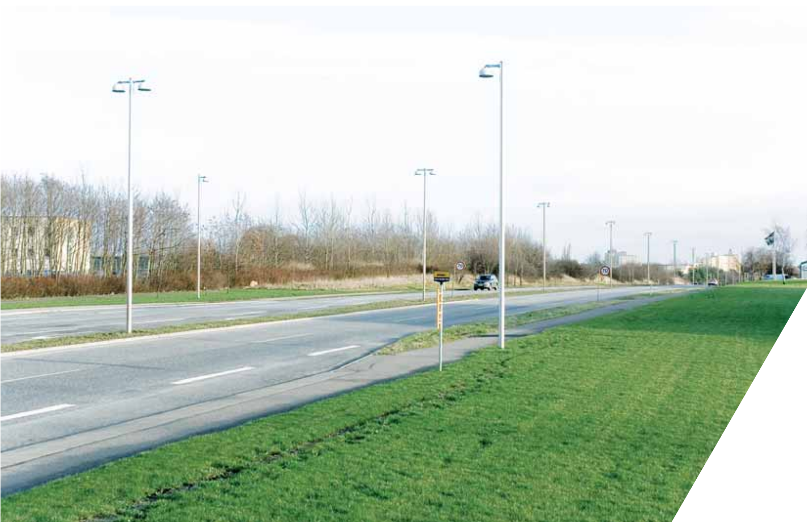
Billede 3-15 Ved busstoppesteder tilpasses masteplaceringen så busstoppestedet er godt belyst. (Måløv Byvej).
