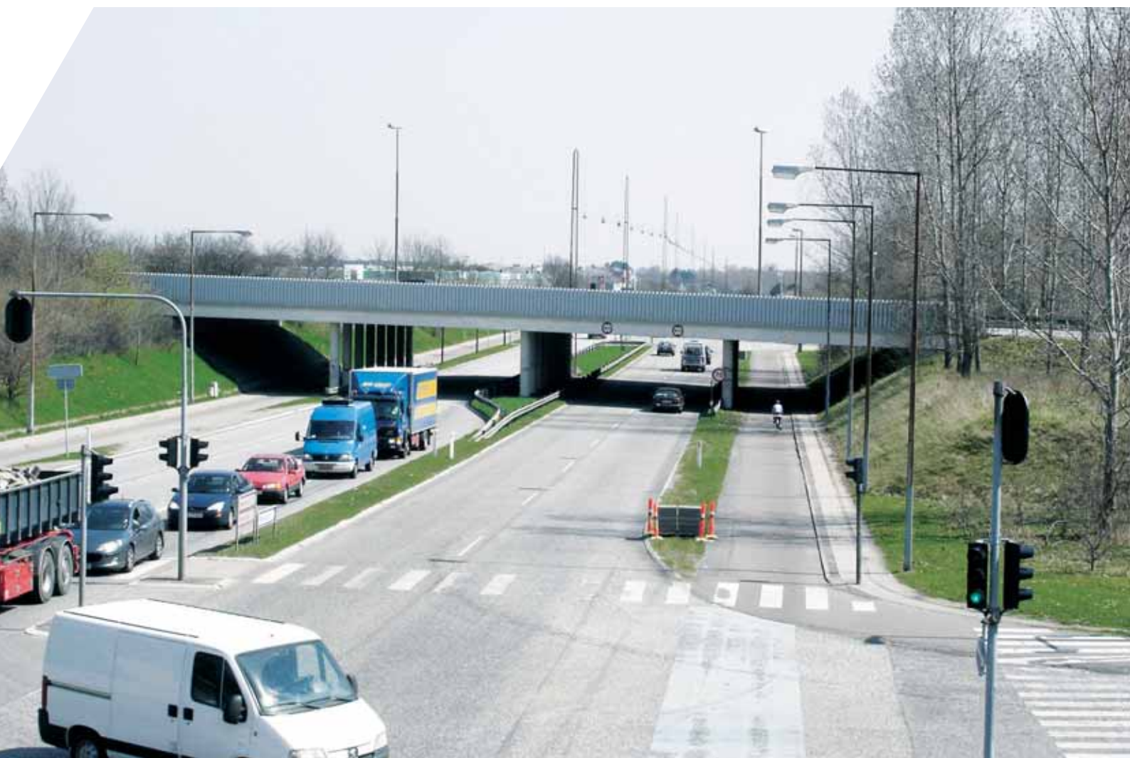
Billede 4-2 Tidstypisk belysningsanlæg fra slutningen af 60'erne med nedhængende skærm og lange arme. (Ballerup Boulevard v. Ring 4).
