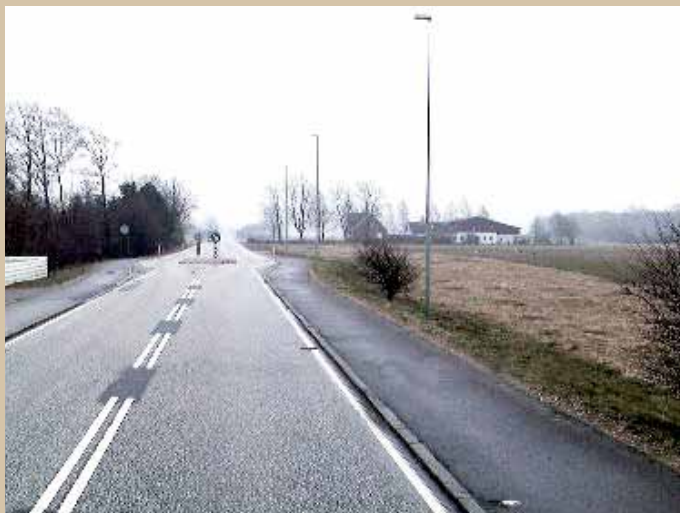
Billede 4-6 Typisk belysningsanlæg på en hovedlandevej. Anlæg med rundkoniske rørmaster og kuffertarmaturer fra ca. 1990 (Vej 133 ved Stokkemærke på Lolland).
