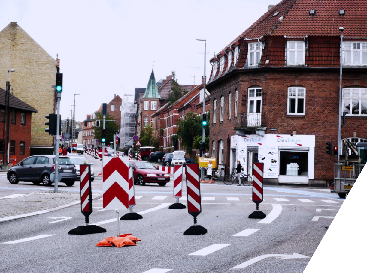
FIGUR 28 Ved vejarbejde ved et signalanlæg kan der udføres en kapacitetskontrol og en evt. justering af signaltiderne/signalprogrammerne.
