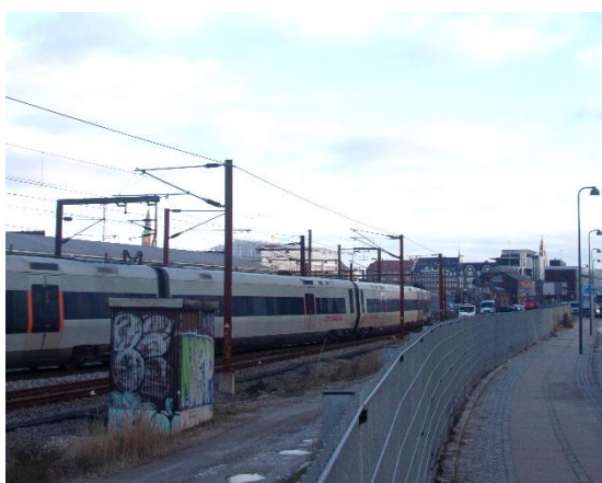
Figur 39. Bygning 1 - Sikringsskab mod jernbanen, set mod nordøst.
