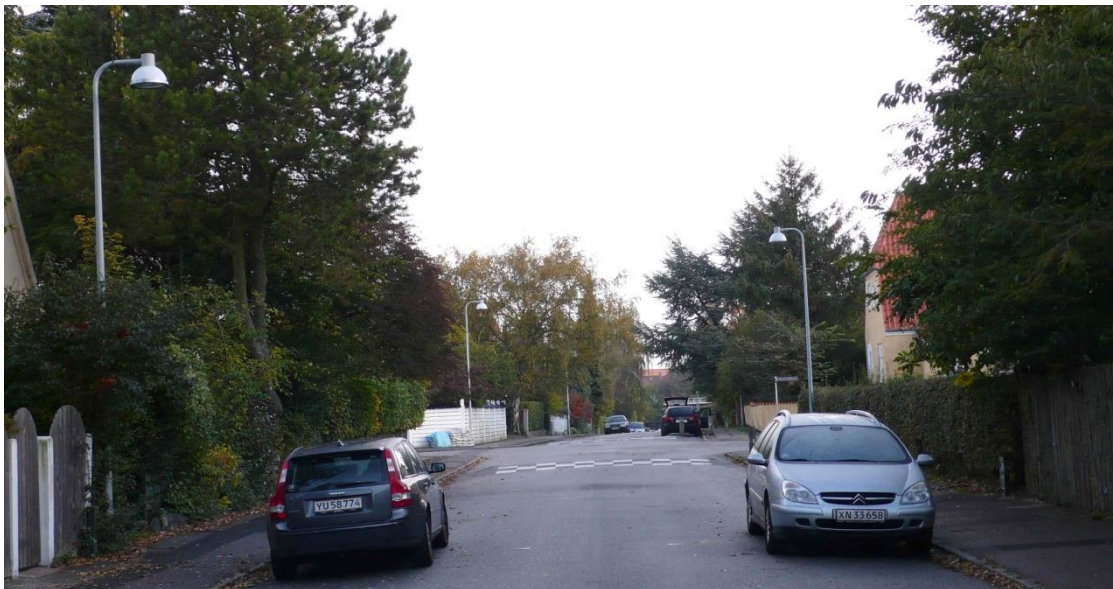
Figur 7.24 Et tosidigt anlæg zigzag på en relativt bred lokalvej.
