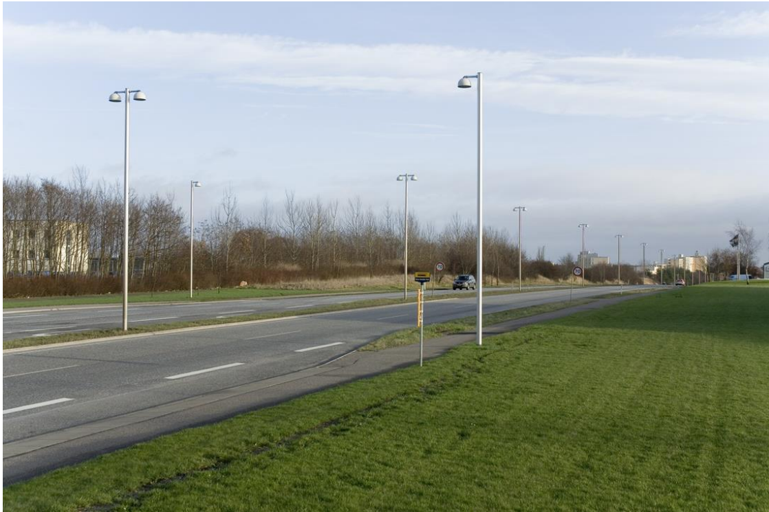
Figur 5.24 Ved stoppesteder tilpasses masteplaceringen, så stoppestedet er godt belyst.
