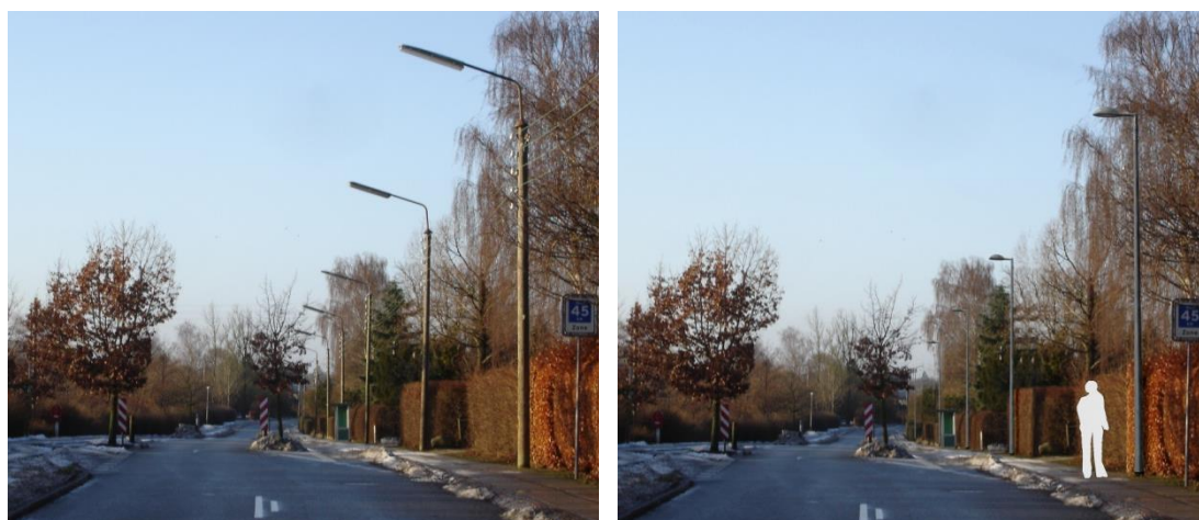
Figur 5.41 Til venstre et anlæg med "uglomme" lange mastearme. Til højre et mere veltilpasset anlæg.
