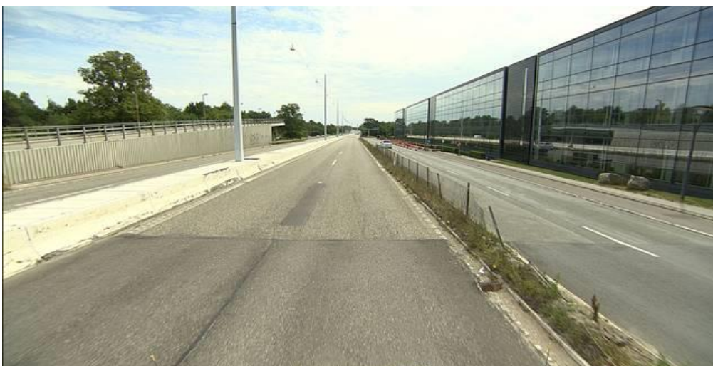
Figur 5.2 Typiske bymotorveje med belysningsanlæg.
