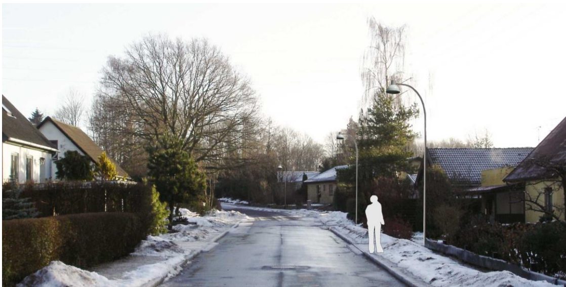
Figur 7.23 Et ensidigt masteanlæg med passende højde på en mindre lokalvej.
