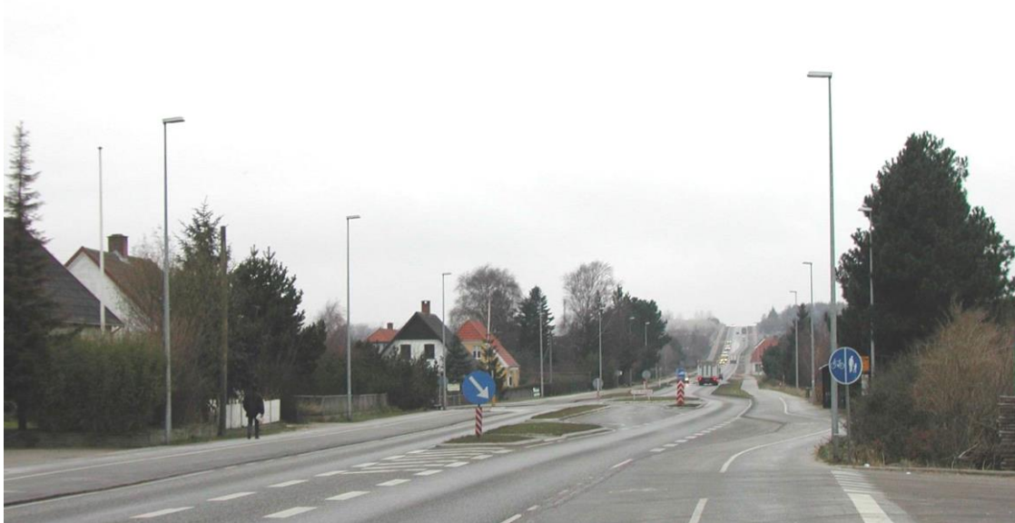
Figur 7.17 De steder, hvor vejen udvider sig med ekstra kørespor, heller og spærreflader, fx ved kryds eller sideveje, vil der ofte være behov for ekstra master med armaturer.
