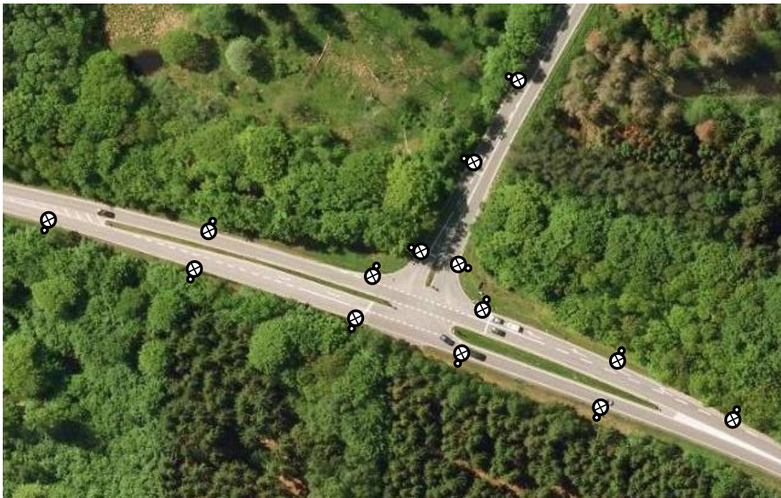
Figur 7.19 Et lysreguleret kryds i åbent land med en typisk fordeling af master med armaturer. Vejen er ellers ubelyst. Kilde: Luftfoto, copyright COWI.
