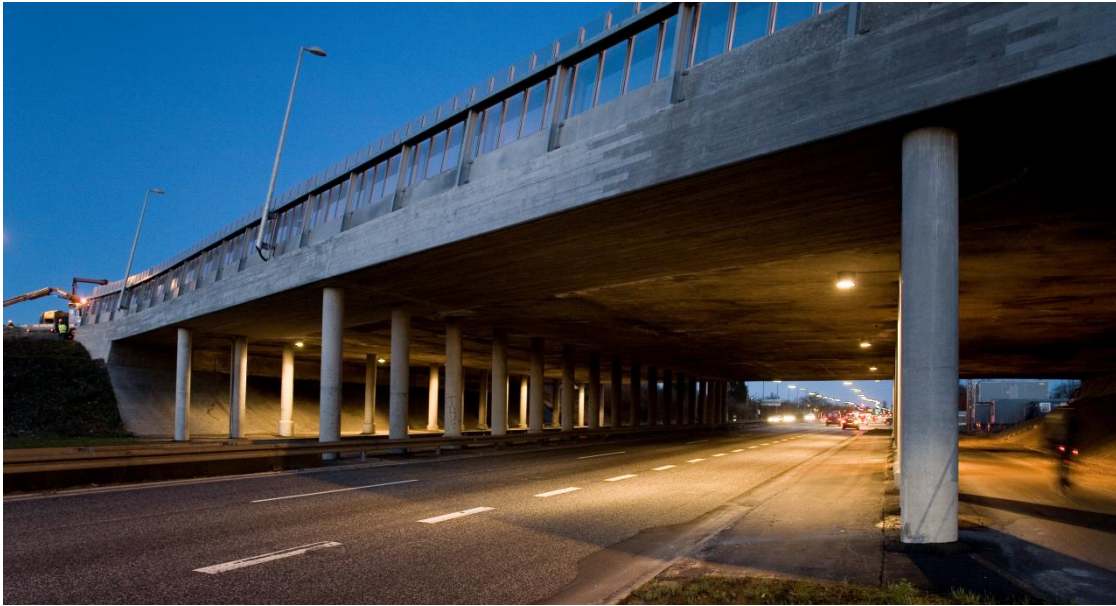
Figur 5.35 Kortere underføringer under en bro med belyst nødspor og cykelsti. På den overførte vej er belysningsanlægget integreret i broens og støjskærmens design.
