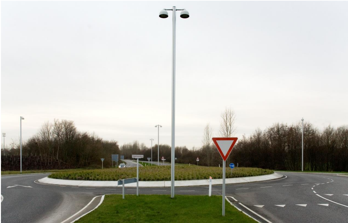
Figur 5.13. Eksempel på belyst rundkørsel på motortrafikvej. Belysningsanlægget tydeliggør det ændrede vejforløb og mindsker risikoen for, at rundkørslen "overses".
