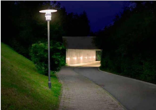
Figur 5.31 Belyst stitunnel, der sikrer trygge forhold for gående og cyklende.
