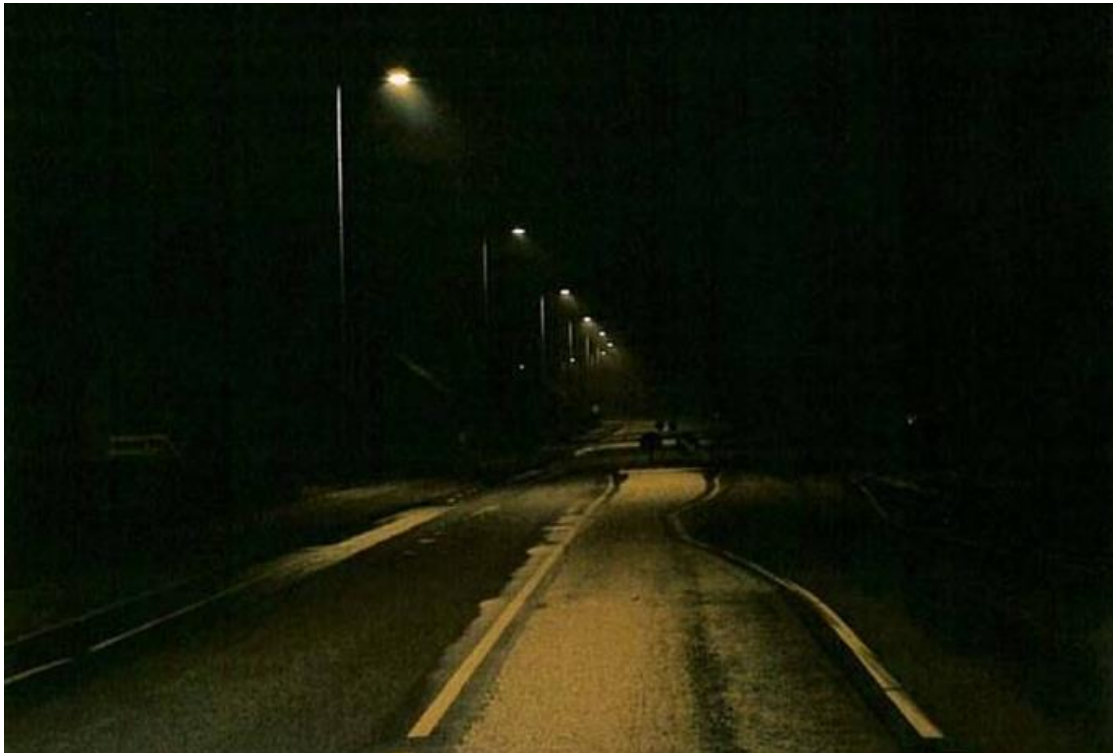
Figur 1.1 En mindre trafikvej, hvor betydningen af vejoverfladens refleksion anskueliggøres. Det lyse materiale på midten af vejen er den oprindelige belægning, som har den tilsigtede luminans. På køresporene på hver side er belægningen repareret med mørkt materiale, der pga. lav refleksion har meget lavere luminans end tilsigtet. Synligheden af vejforløbet og eventuelle forhindringer er reduceret betydeligt ved de mørke belægninger i forhold til de lyse.
