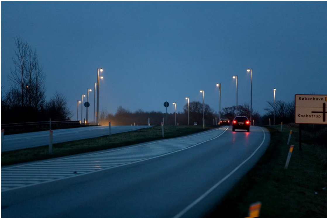
Figur 5.7 Belysningen bidrager væsentligt til at gøre opmærksom på krydset, som ellers knapt ses pga. vejens krumning.
