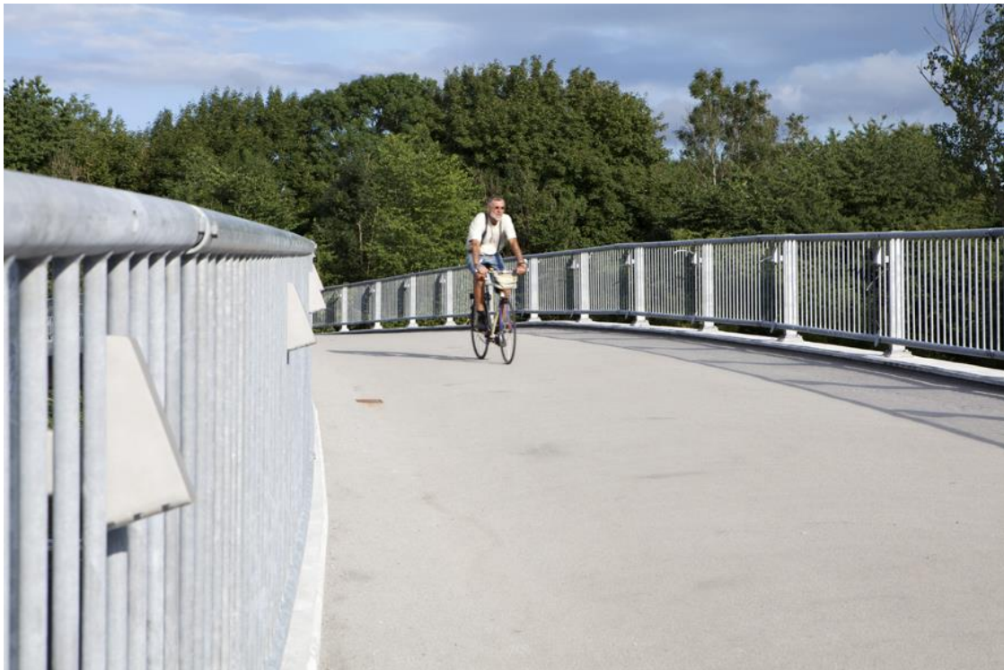
Figur 5.28 Stibro belyst med armaturer integreret i rækværk.
