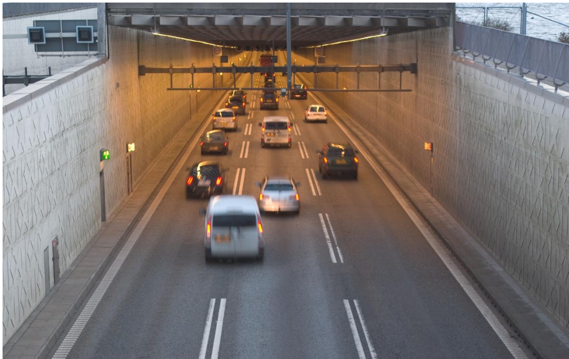
Figur 5.37 Længere vejttunnel med dagslysgitter i indkørselszonen.
