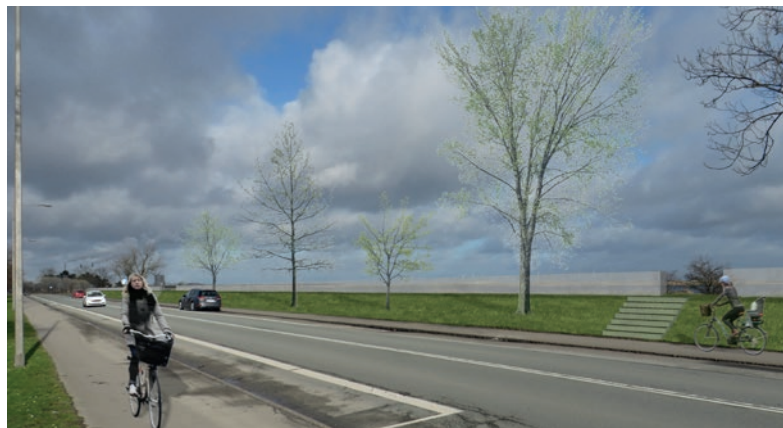
Figur 10.3 Hvor der er anlagt et mindre dige og etableret en plint.
