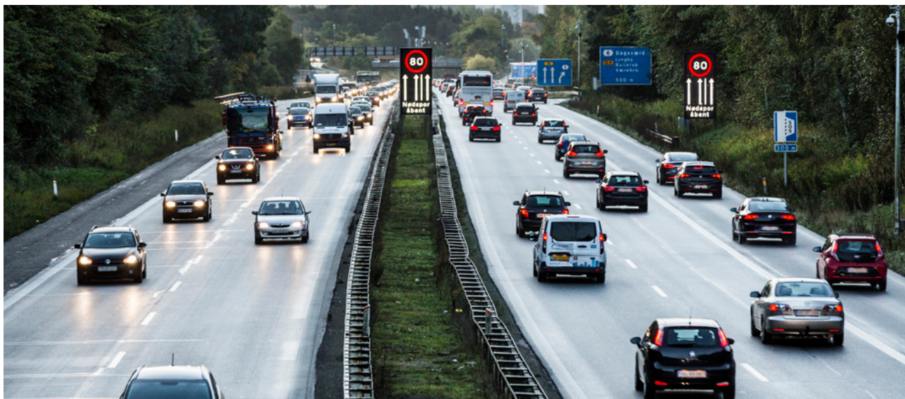
ITS-system ved kørsel i nødsporet på Hillerød-motorvejen.
