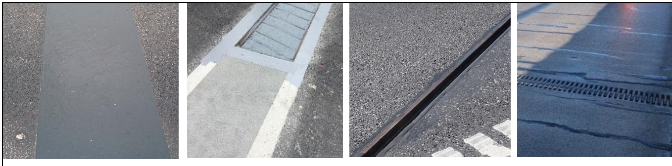
Støbt fuge, bituminøs
